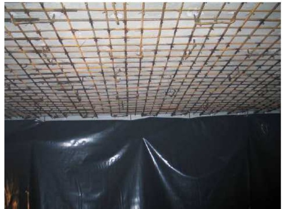
Figura 51 - Armadura de recuperação/reforço estrutural em laje.
