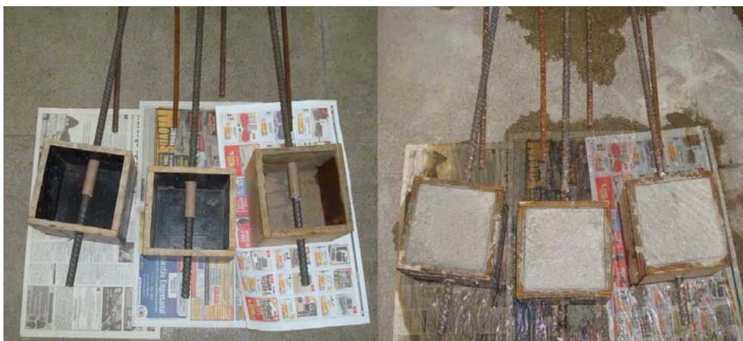
Figura 58 - Direção da concretagem dos Corpos de Prova.
