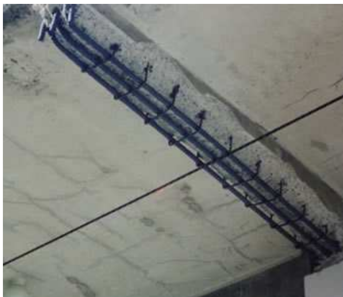
Figura 52 - Armadura transversal chumbada ao concreto existente para recuperação de viga de concreto armado.
