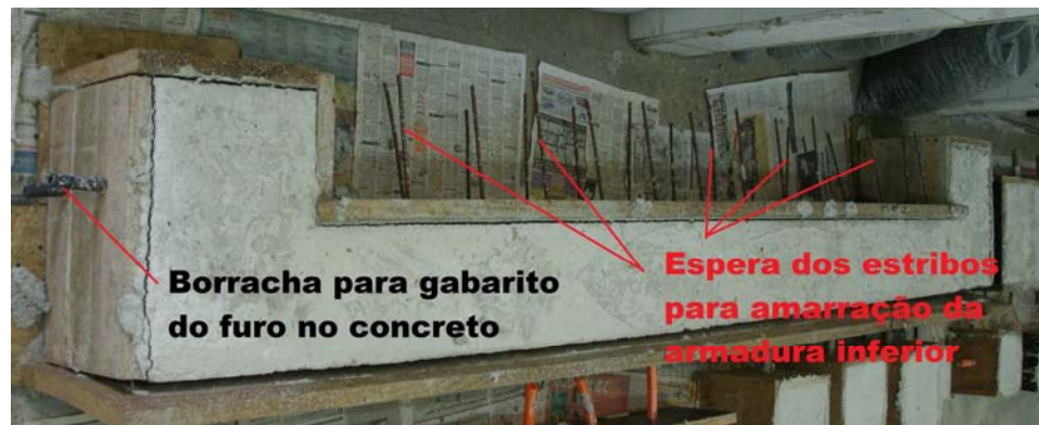
Figura 57 - Moldagem parcial da viga 2 com as esperas dos estribos para fixação da armadura positiva.
