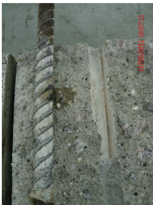
Figura 113 - Detalhe do cisalhamento do concreto entre as nervuras da barra no CP-2.
