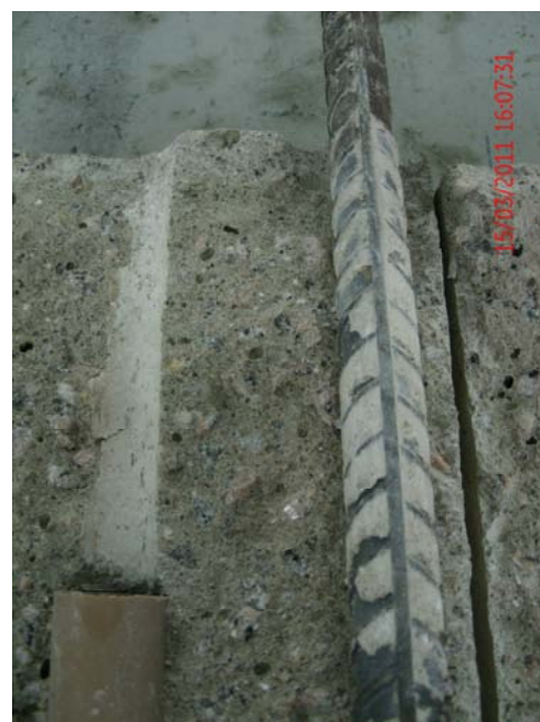
Figura 114 - Ruptura do CP-5 e detalhe do cisalhamento do concreto entre as nervuras que configura o deslizamento da barra
