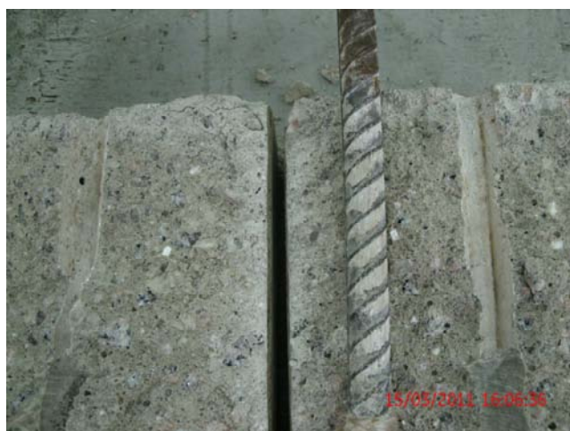
Figura 112 - Ruptura do CP-2 com detalhes do deslizamento entre o aço e o concreto.
