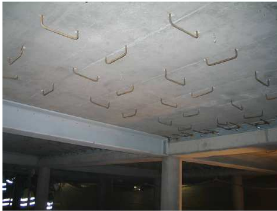
Figura 50 - Conectores colados/chumbados na laje existente para compor armadura de recuperação/reforço.
