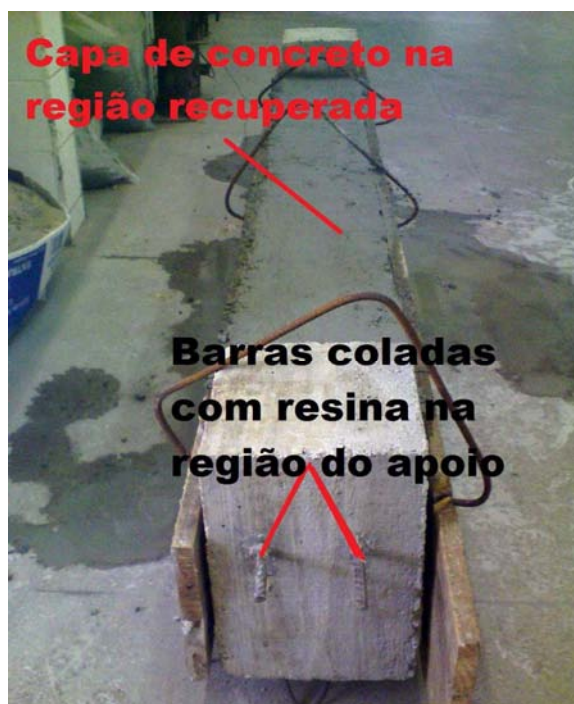
Figura 71 - Viga 2 após a 2ª fase de concretagem.
