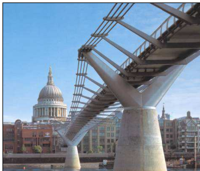
Figura 1.1 – Vista Inferior do tabuleiro e pilares de suporte da Passarela do Milênio [1] em Londres – Inglaterra.
