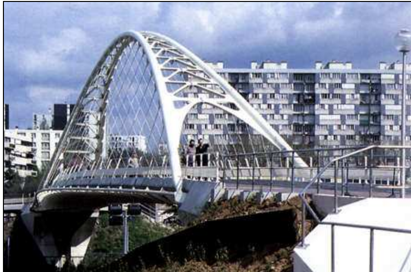
Figura 1.2 - Passarela Oudry-Mesly [2]– França.
