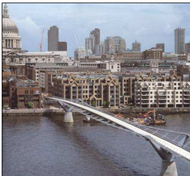
Figura 1.6 - Vista aérea da Passarela do Milênio [1] em Londres – Inglaterra.
