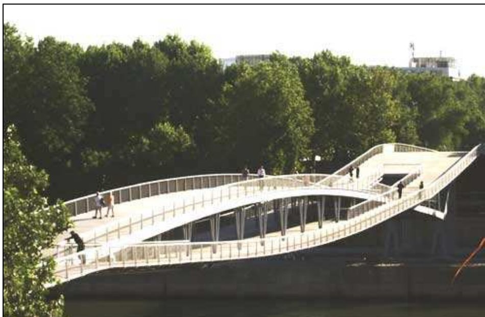
Figura 1.7 - Passarela Simone de Beauvoir [7], sobre o Rio Sena – França.
