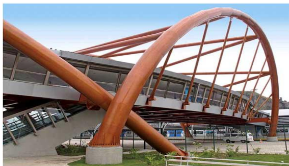
a) Passarela – Rio de Janeiro – ligações CHS
