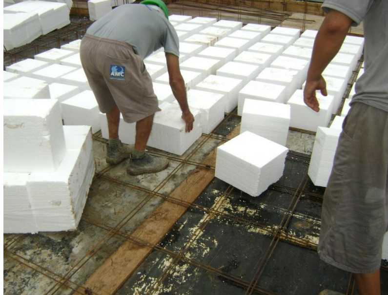
Figura 1 – Laje nervurada com EPS [4]
