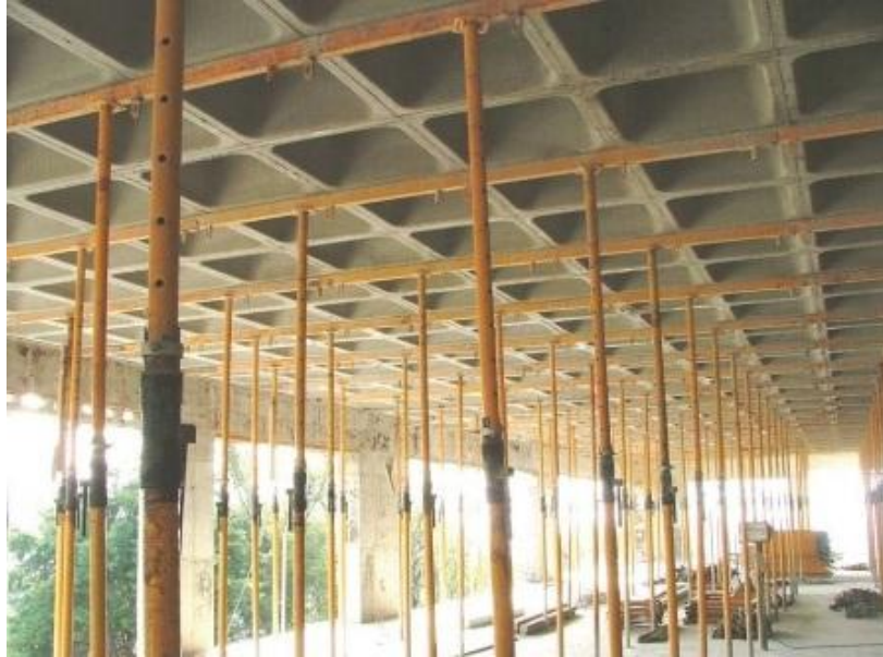
Figura 2 – Escoramento de lajes nervuradas [6]
