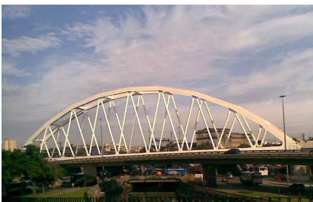
e) Viaduto do Metrô, Rio de Janeiro[3]
