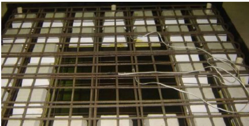
Figura 26 – Aspecto da instrumentação da armadura de cisalhamento, (SOUZA, 2007)
