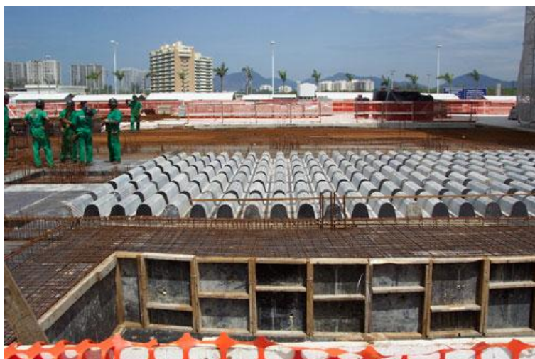
Figura 16 – Aspecto, antes da concretagem, de fôrmas de uma laje, (REDUZCON, 2012)
