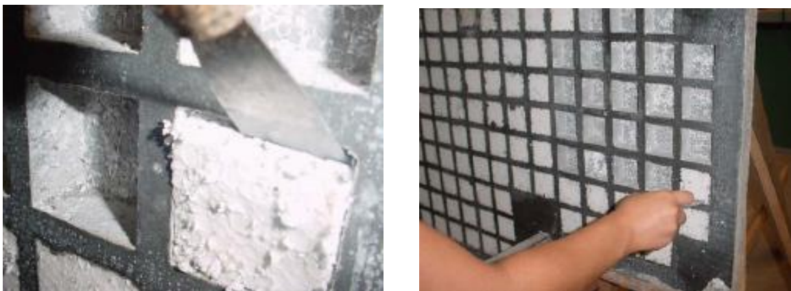
Figura 23 e 24 –Retirada dos moldes de EPS, com o auxílio de espátula, (SCHWETZ, 2005)
