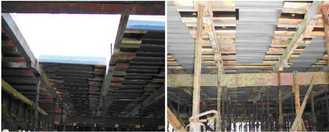
Figura 17 – Aspecto do escoramento e montagem de fôrmas
