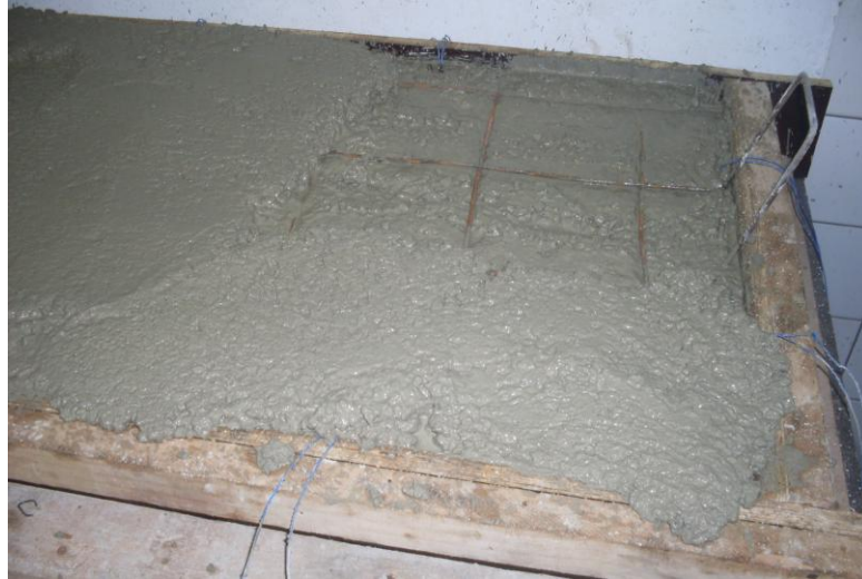
Figura 79 – Concretagem e posicionamento da armadura não estrutural
