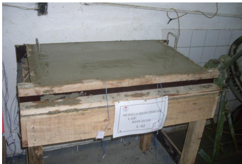
Figura 82 – PI-02 após a concretagem
