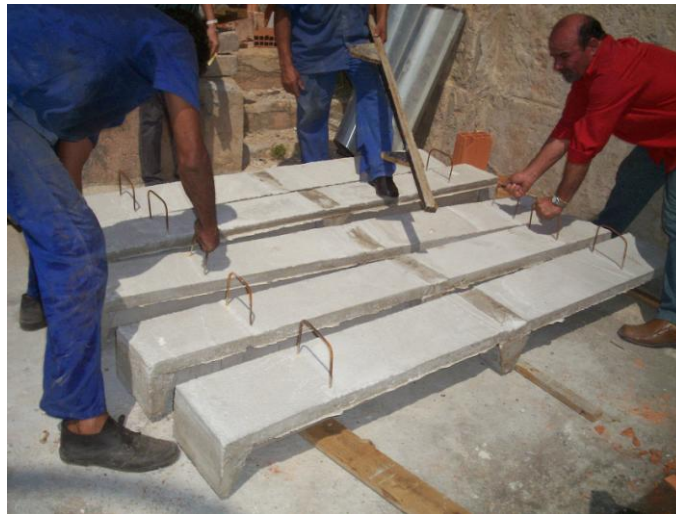
Figura 66 – Aspecto, após a desforma, das faixas dos modelos I e II
