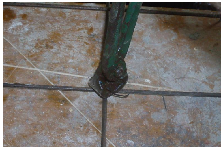
Figura 71 – Detalhe da fixação das armaduras
