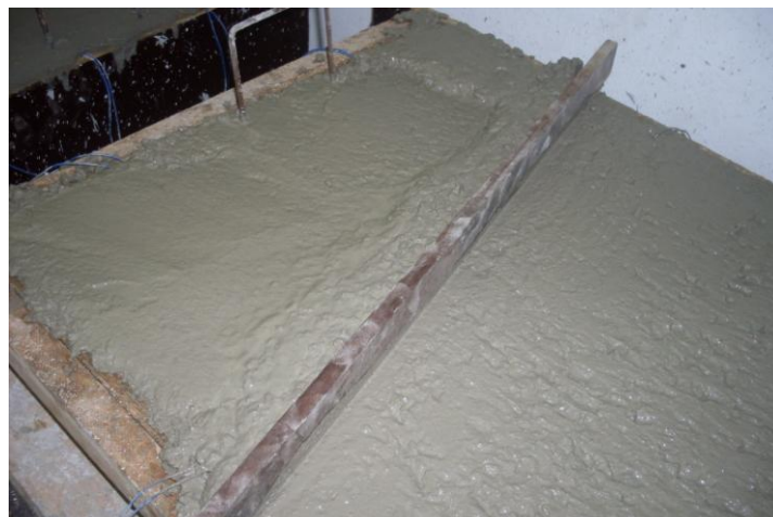
Figura 80 – Regularização da superfície do painel de laje PL-02
