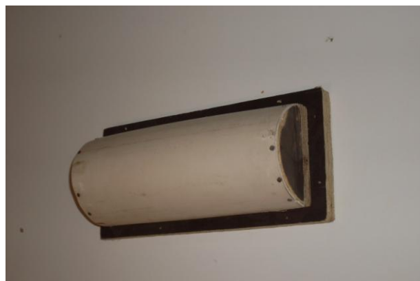
Figura 67 – Aspecto de um meio-barrote reduzido
