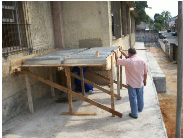
Figura 60 – Painel para concretagem das faixas dos modelos I e II
