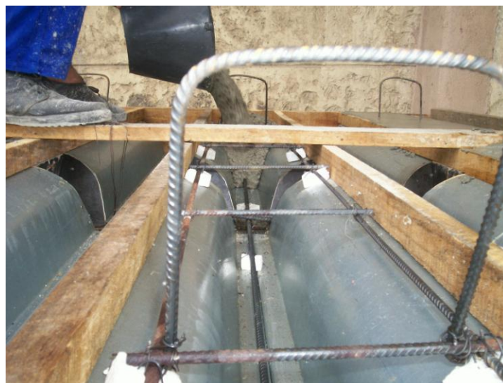
Figura 65 – Lançamento do concreto na forma dos modelos I e II
