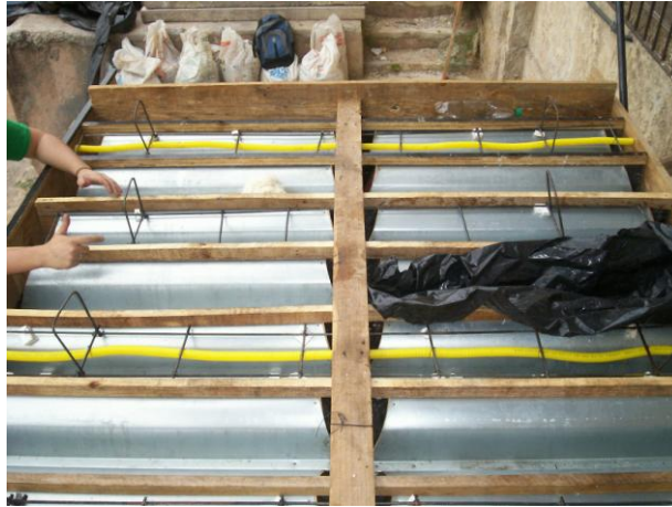
Figura 62 – Painel para concretagem dos elementos dos modelos I e II
