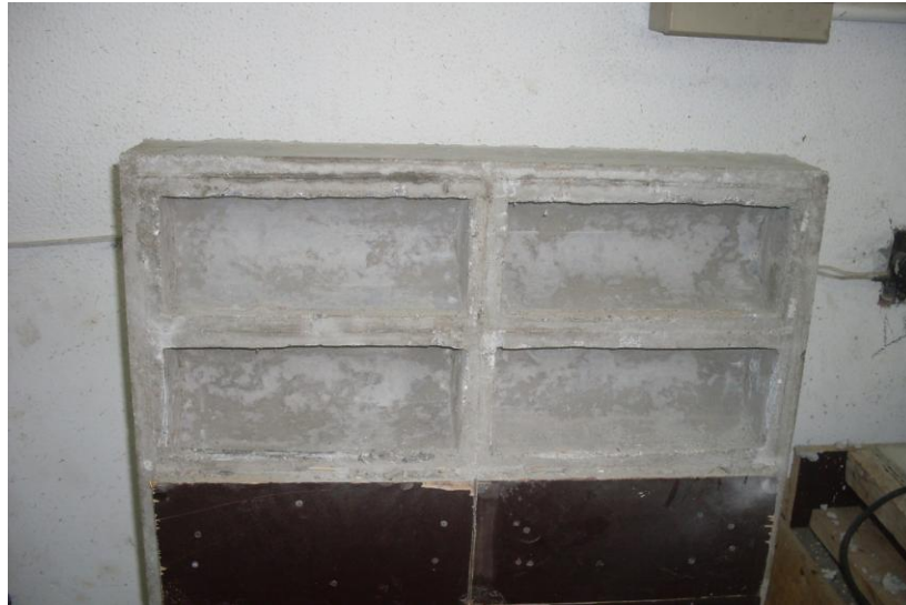
Figura 83 – PL-01 após a retirada de parte das fôrmas de barrotes reduzidos
