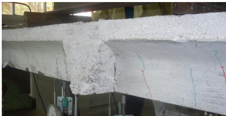
Figura 149 – Aspecto das fissuras da viga V-2A
