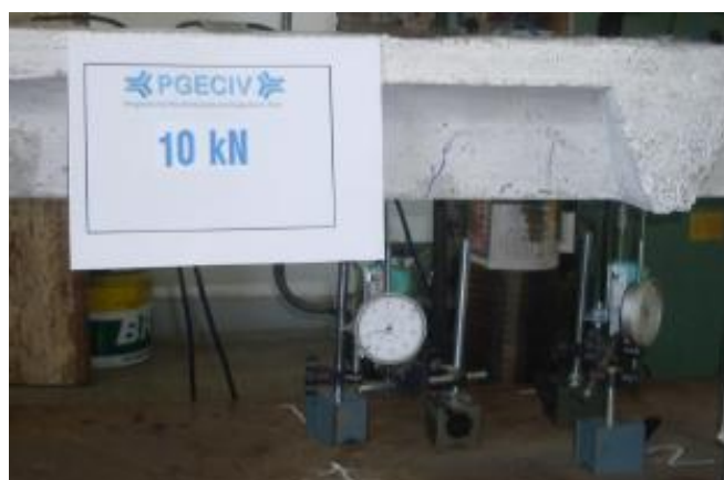
Figura 150 – Aspecto das fissuras da viga V-2A para uma carga de 10kN
