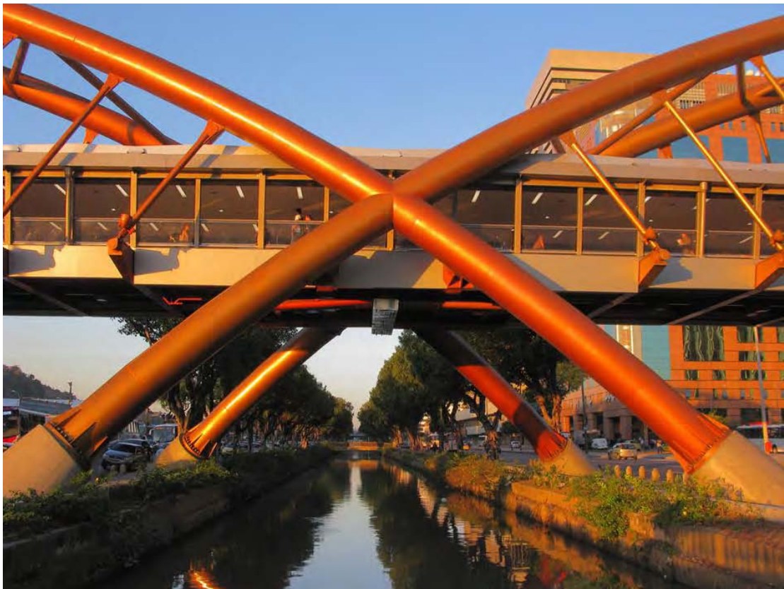
Figura 1 – Metrô Rio: Estação Cidade Nova, Rio de Janeiro – Brasil [2].
