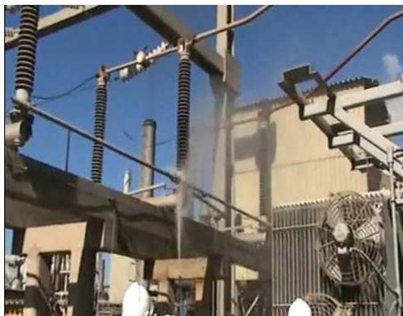
a) Lavagem de isolador
