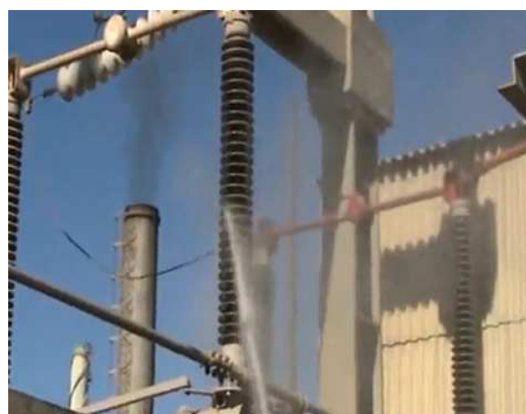
b) Lavagem de isolador
