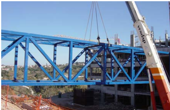
e) Passarela em Coimbra – Hospital Pediátrico
