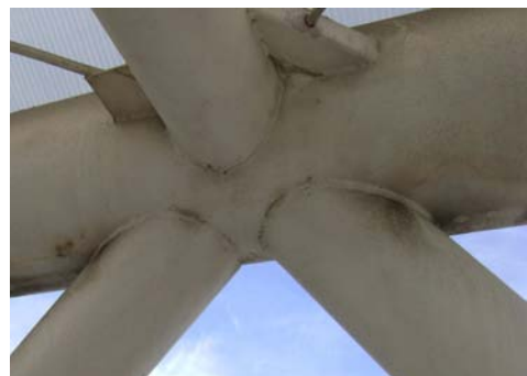
h) Detalhe da passarela de São Cristóvão
