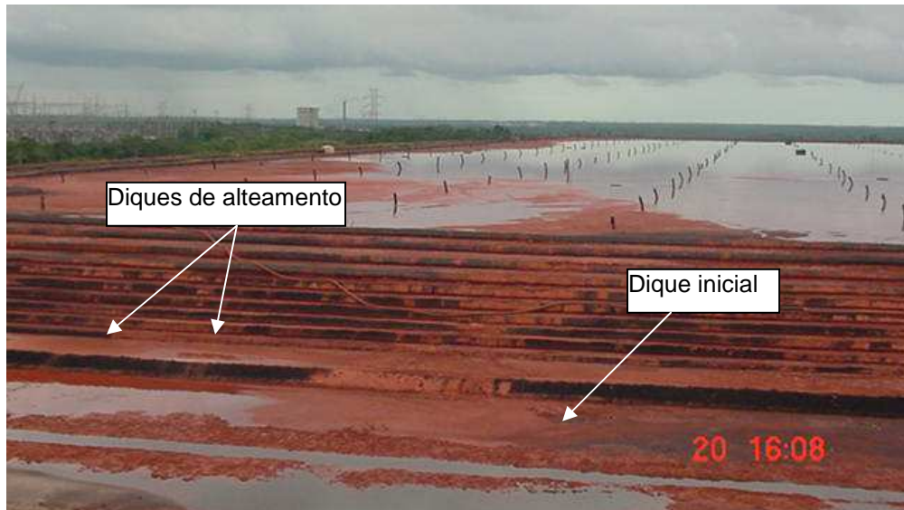
Figura 3.4. Área de Resíduos 2 durante o alteamento a montante (Costa Filho et al, 2006)
