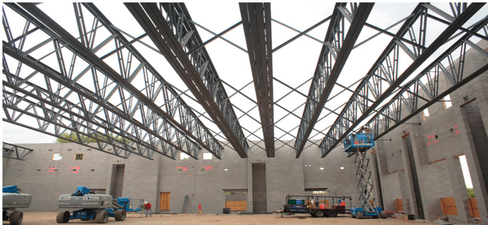
Figura 3.2 - Vigas treliçadas (joists) para longos vãos
