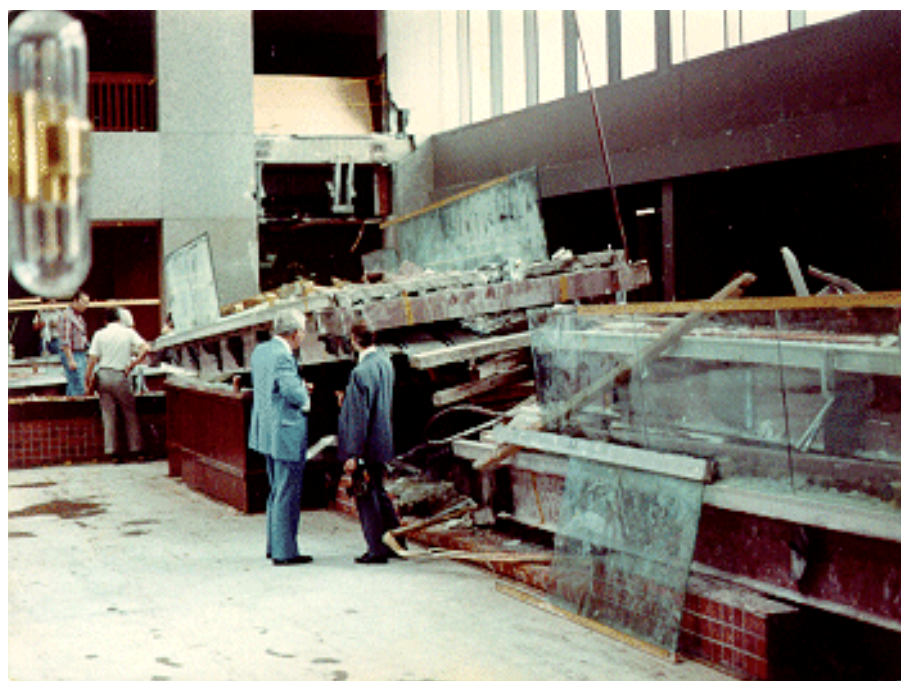
Figura 1.2 - Colapso da passarela do hotel Hyatt Regency, Kansas city, EUA [1981] [3]
