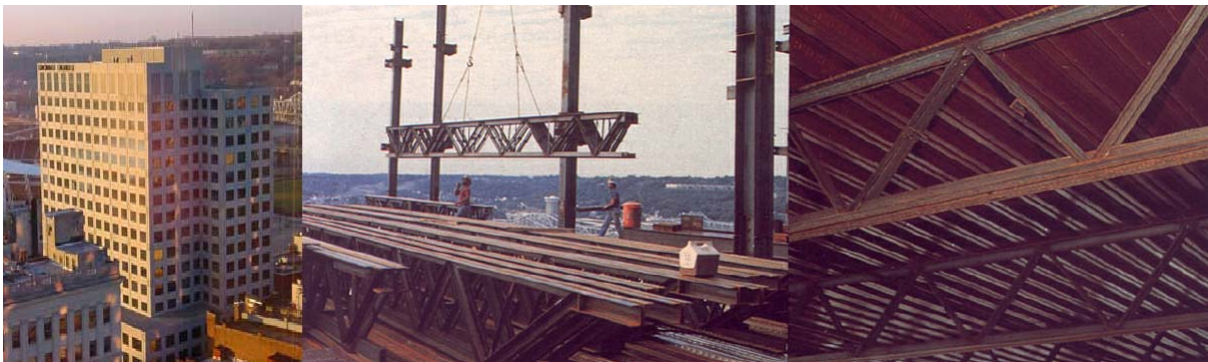
Figura 3.1 - Construção do 312 Elm Building, Cincinnati, Ohio - Fabricação em série [57]
