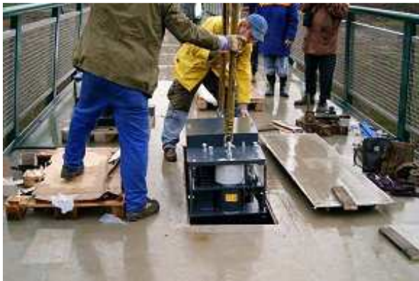
a) Vista do içamento dos ADSs.
