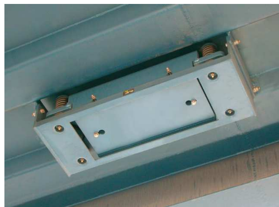
b) Um dos dois ADSs de 520kg instalados
