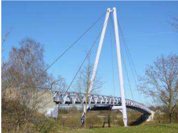
a) Vista geral da passarela.
