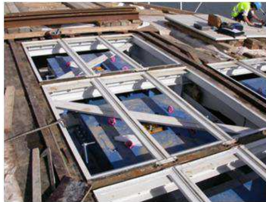
Figura 11 – ADSs horizontais instalados na passarela Pedro e Inês [15].
