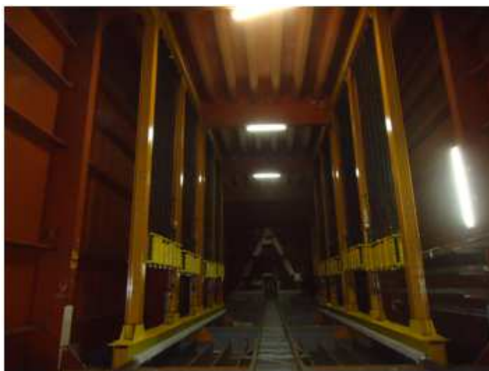
Figura 35 – ADSs projetados por Battista [68] e instalados na ponte Rio-Niterói, Brasil. Acervo pessoal, 2013.
