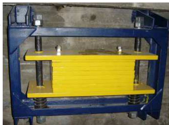
b) Atenuador dinâmico sintonizado
