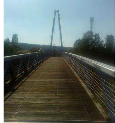
b) Vista do piso em madeira.
