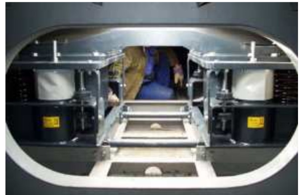
b) ADSs instalados no interior da viga caixão.
