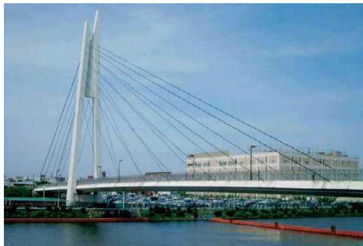
Figura 3 – Vista geral da passarela Toda Park Bridge [8].
