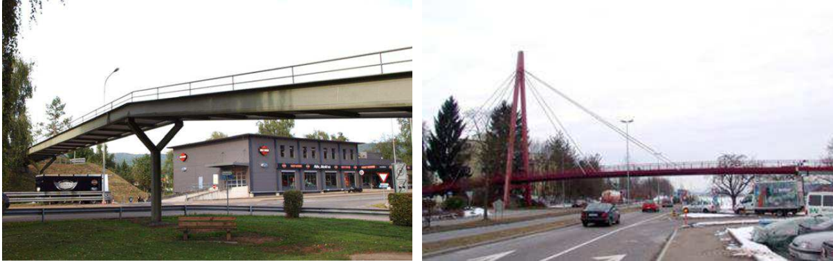
a) Passarela em vigas metálicas.
