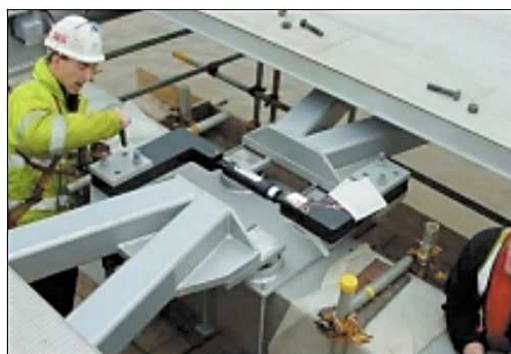
Figura 34 – Amortecedor visco-fluido [4].
