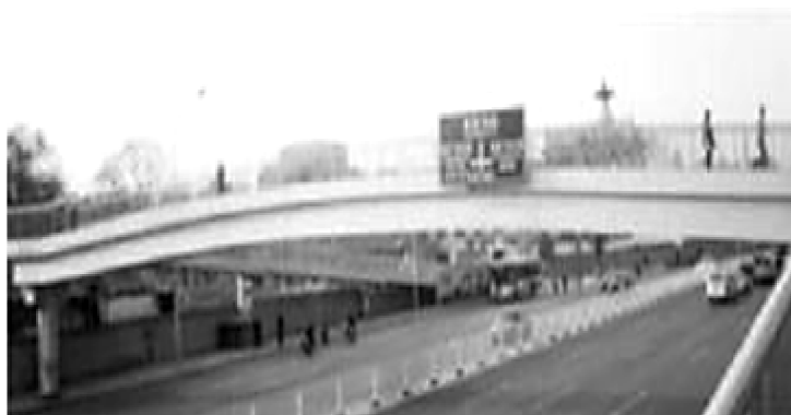
a) Passarela em Pequim - China
