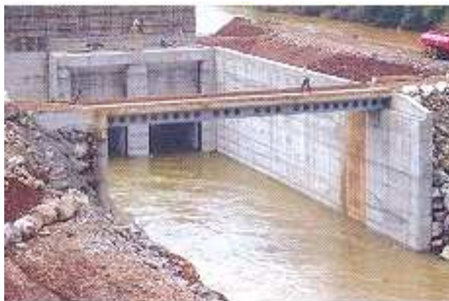
Figura 2 - Passarela biapoiada de 20 metros [2].
