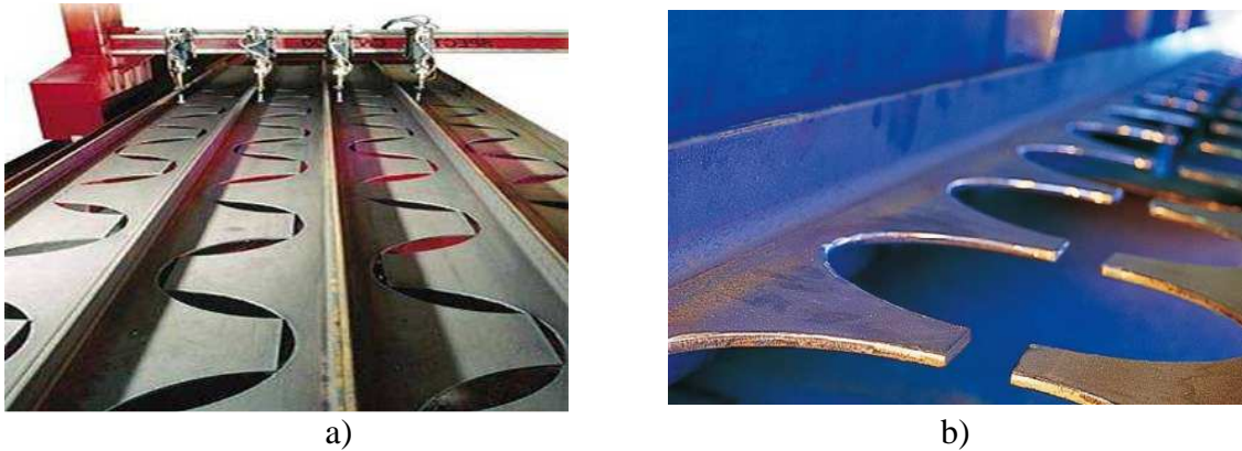
Figura 21 - Fabricação de vigas celulares: a) Corte da alma; b) Soldagem [1].
