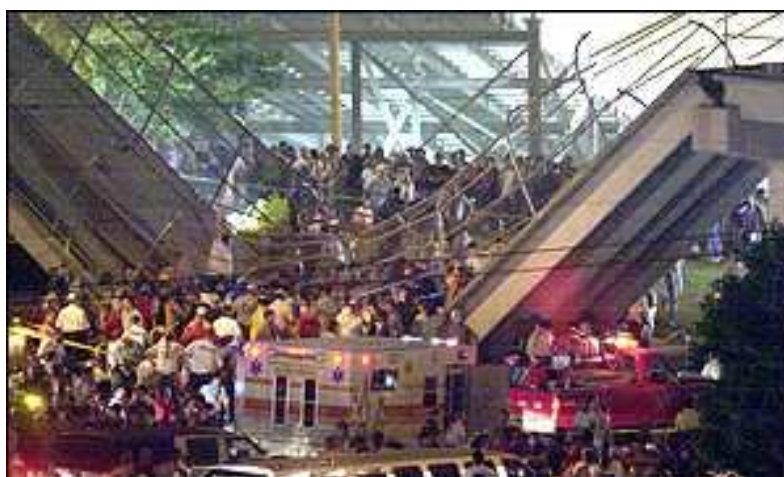
Figura 5 - Desabamento de uma passarela na Carolina do Norte/EUA [5]
