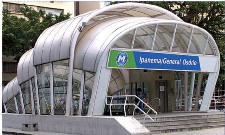
b) Estação Ipanema/General Osório – Rio de Janeiro [12]
