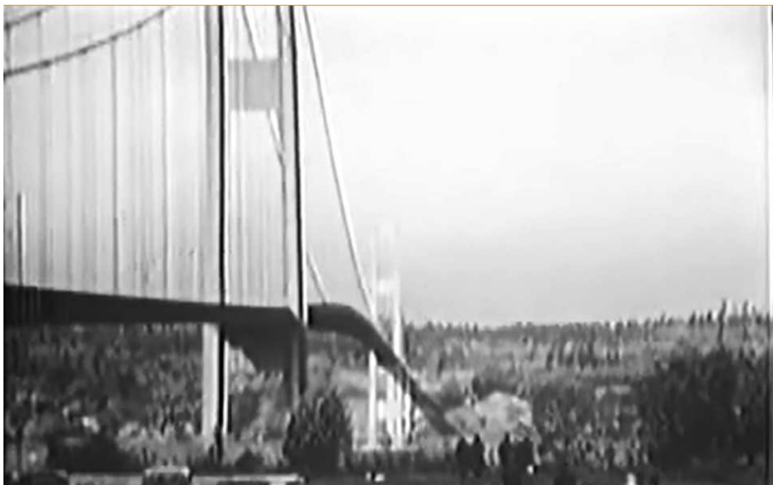
Figura 1 - Início do efeito da ressonância da estrutura com o vento.
