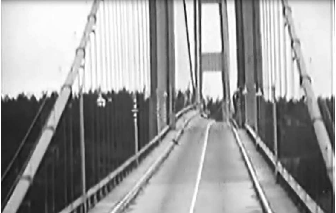
Figura 2 - Vista longitudinal da ponte apresentando o efeito da ressonância.
