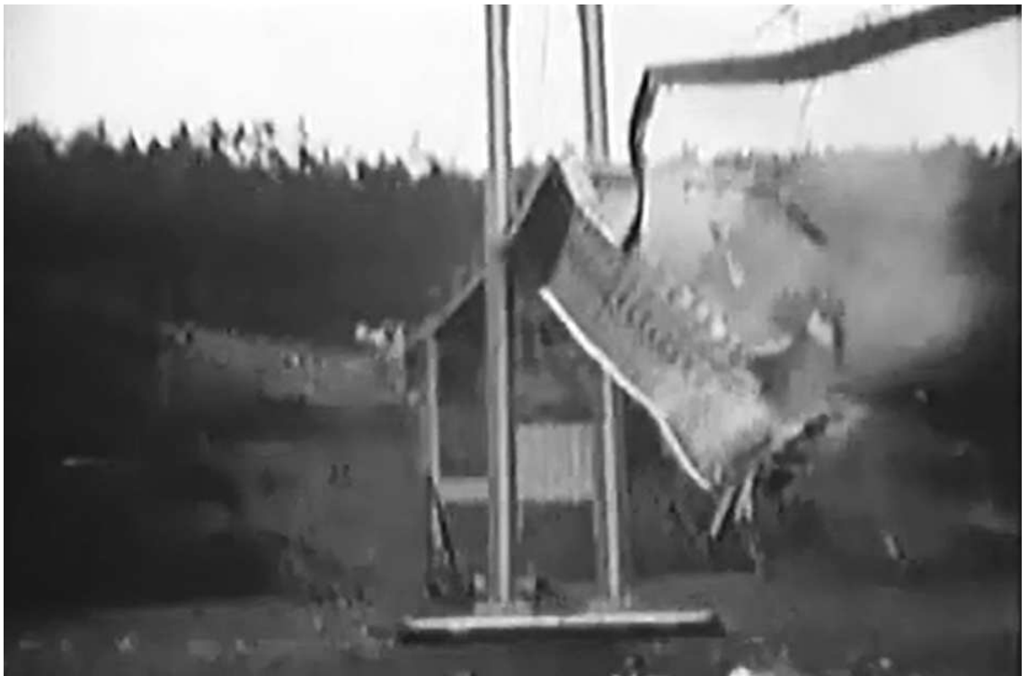
Figura 3 - Colapso da estrutura provocado pelo fenômeno da fadiga.
