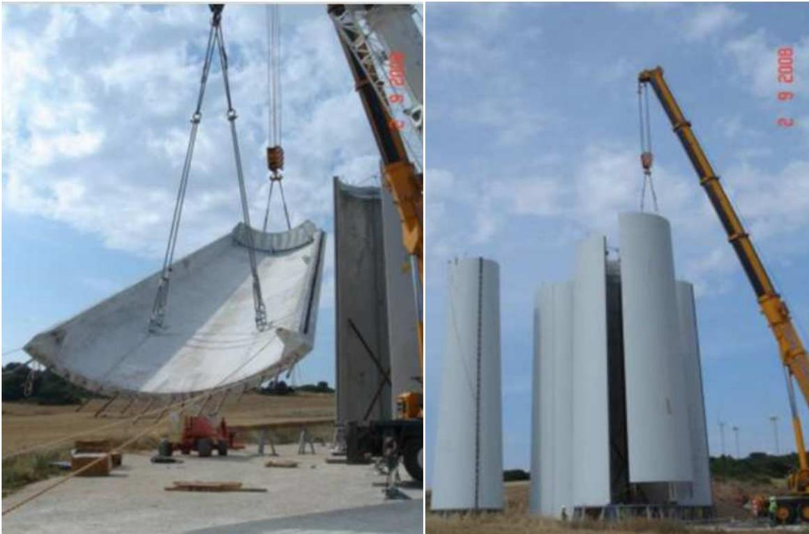
Figura 10 – Montagem de torre pré-fabricada de concreto [11].
