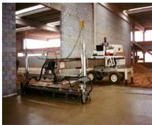
Figura 3.6 – Equipamento: Laser Screed (Rodrigues, 2006)
