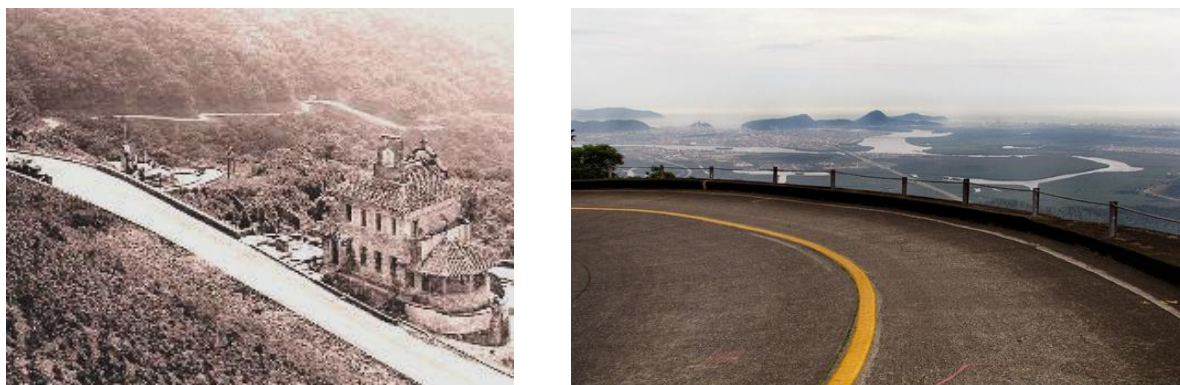
Figura 1.2 – Rodovia Caminho do Mar (São Paulo)
