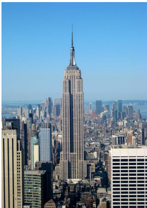
Figura 7 - Empire State Building em Nova Iorque, nos EUA. Altura: 443 metros [11].
