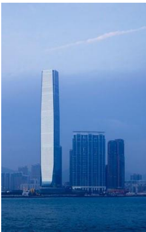
Figura 1 - International Commerce Centre em Hong Kong, na China. Altura: 484 metros [6].
