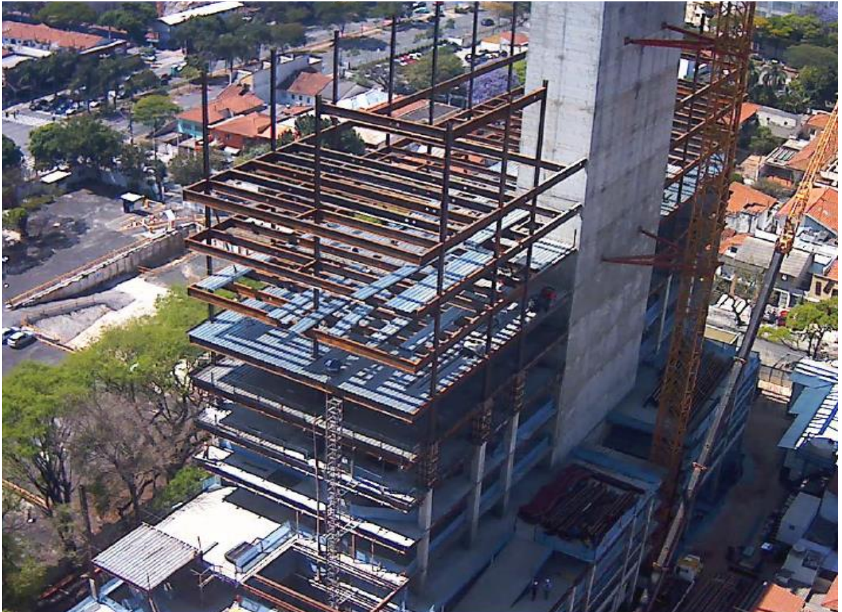
Figura 10 – Fase construtiva do edifício The One [68].
