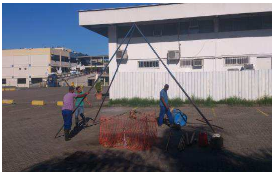
Figura 53 – Ensaio SPT sendo realizado no interior do aterro (SP4-B).
