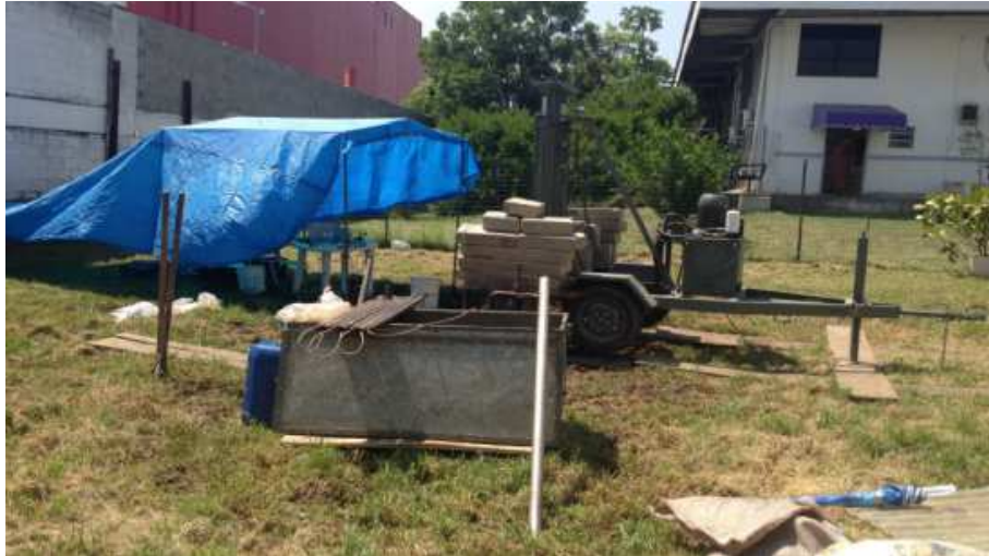
Figura 54 – Ensaio de piezocone sendo realizado externo à área construída (CPTU-01, CPTU-02, CPTU-03).
