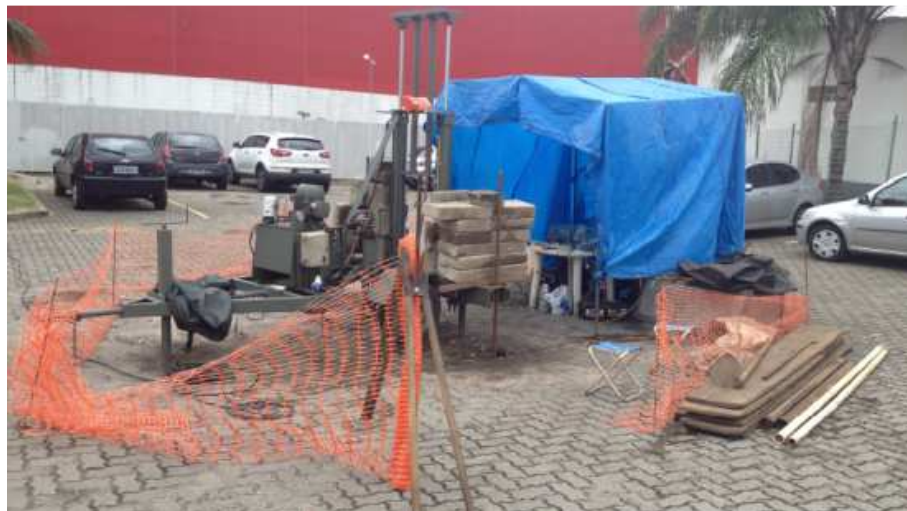
Figura 55 – Ensaio de piezocone sendo realizado no interior do aterro (CPTU-04).
