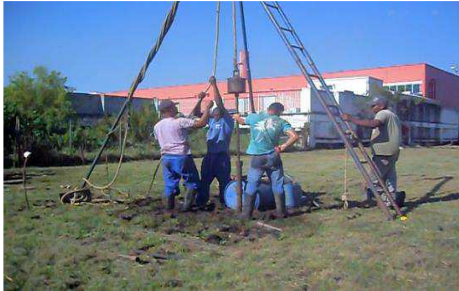
Figura 52 – Ensaio SPT sendo realizado externo à área construída (SP1-B, SP2-B, SP3-B).
