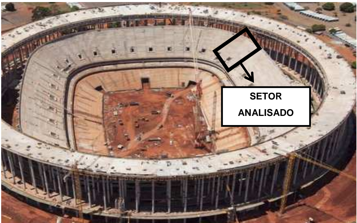
Figura 34 - Detalhe do setor da arquibancada analisado neste trabalho (LIMA, 2013)
