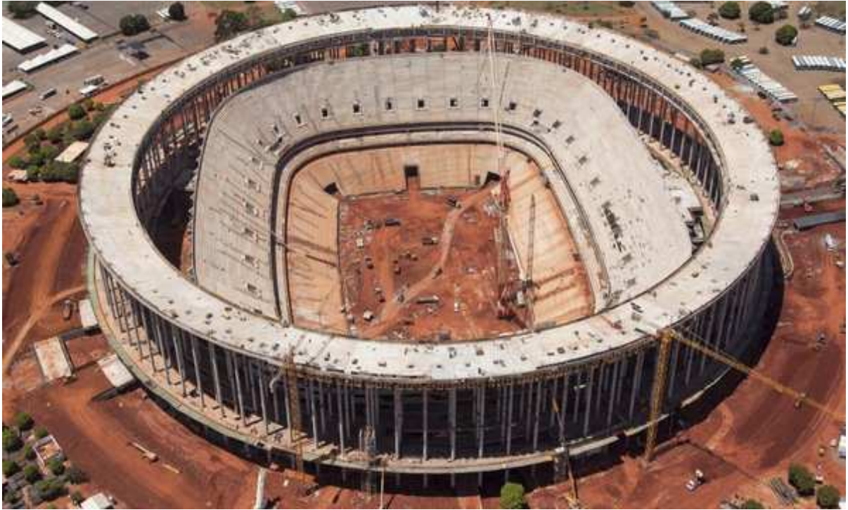
Figura 33 - Estádio Nacional de Brasília durante construção (LIMA, 2013)
