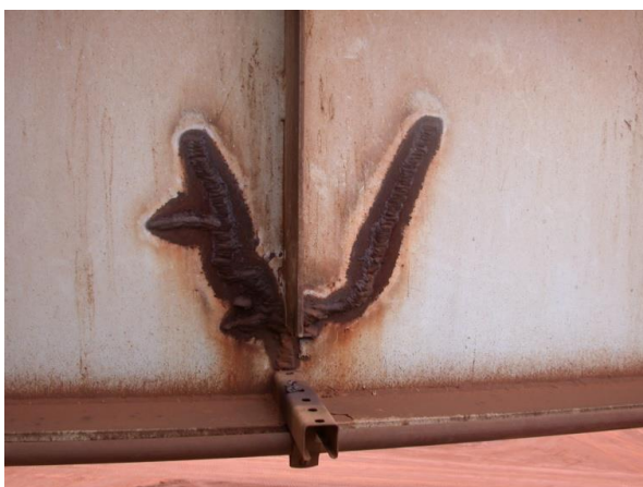
a) Detalhe vista frontal
