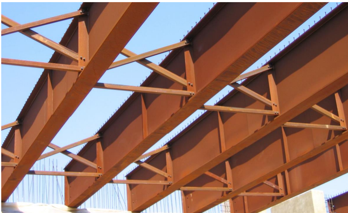
Figura 1 - Concepção estrutural de ponte mista típica, Whisenhunt (2004).
