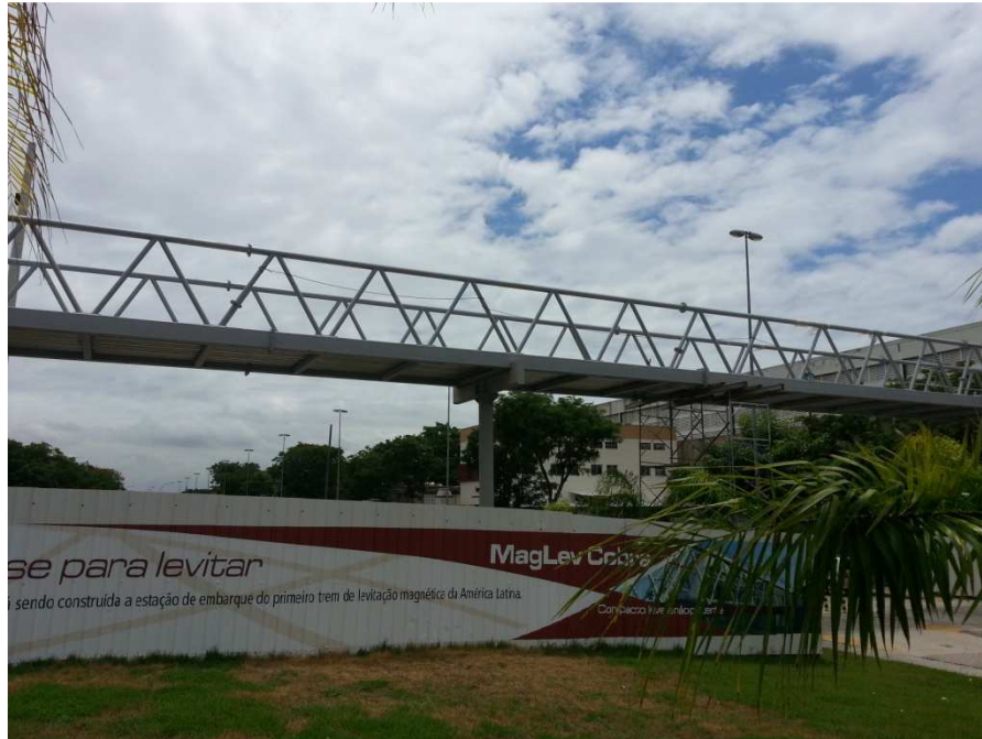
Figura 4 - Reforço em um Treliça de tamanho real – UFRJ - Rio de Janeiro
