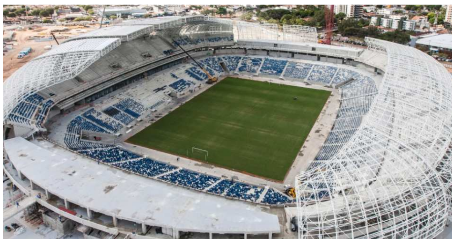
b) Estrutura Estádio das Dunas – Natal [2]
