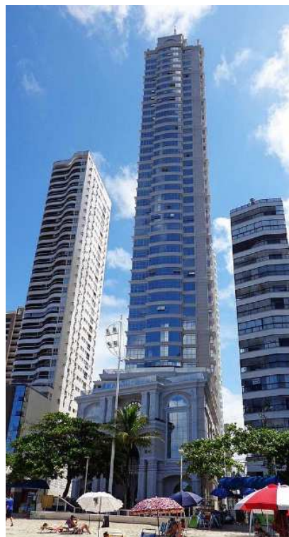
Figura 2 - Edifício Millennium Palace [5]
