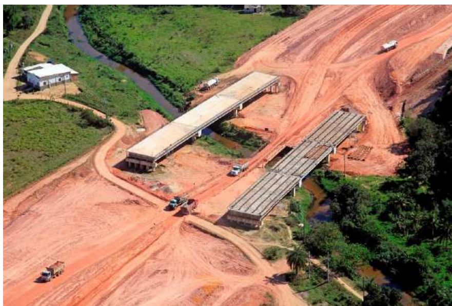
Figura 18- Vista da execução das Pontes sobre o Rio Capivari (Pires, 2013)
