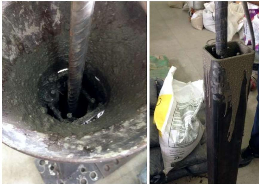
Figura 54 – Concretagem e adensamento com vibrador.
