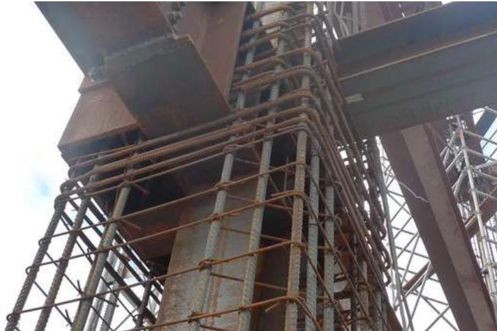
Figura 11 – Pilar misto – perfil de aço envolto por concreto armado [50].
