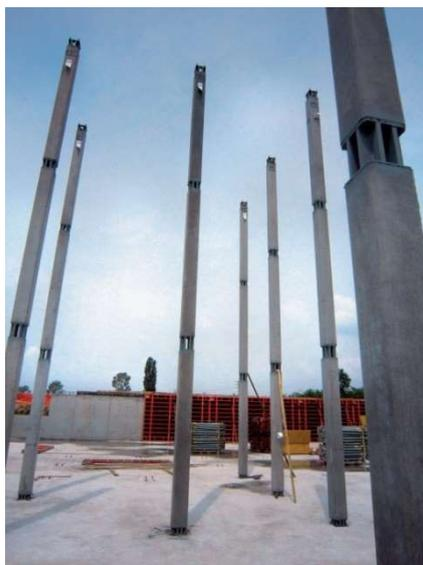
Figura 12 – Pilar misto – Perfil tubular de aço preenchido por concreto [51].
