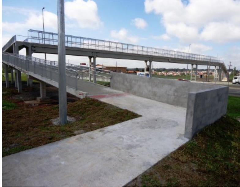
Figura 1 - Passarela com elementos pré-moldados [1]
