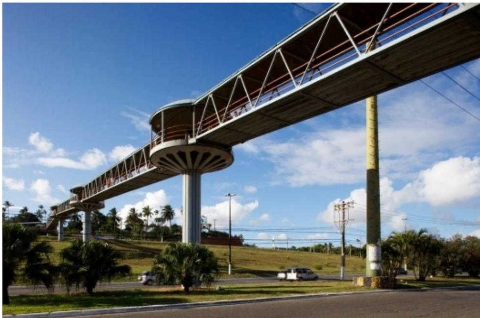
Figura 2 - Passarela em estrutura pré-fabricada treliçada em aço estrutural [2]
