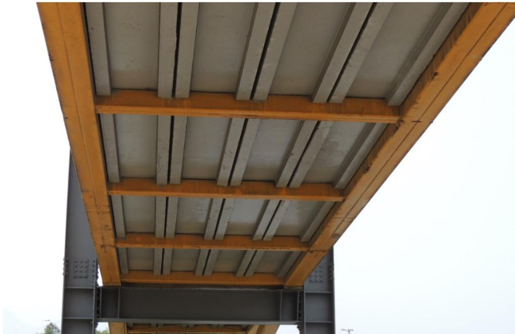
Figura 30 – Vista inferior dos elementos de laje pré-moldadas
