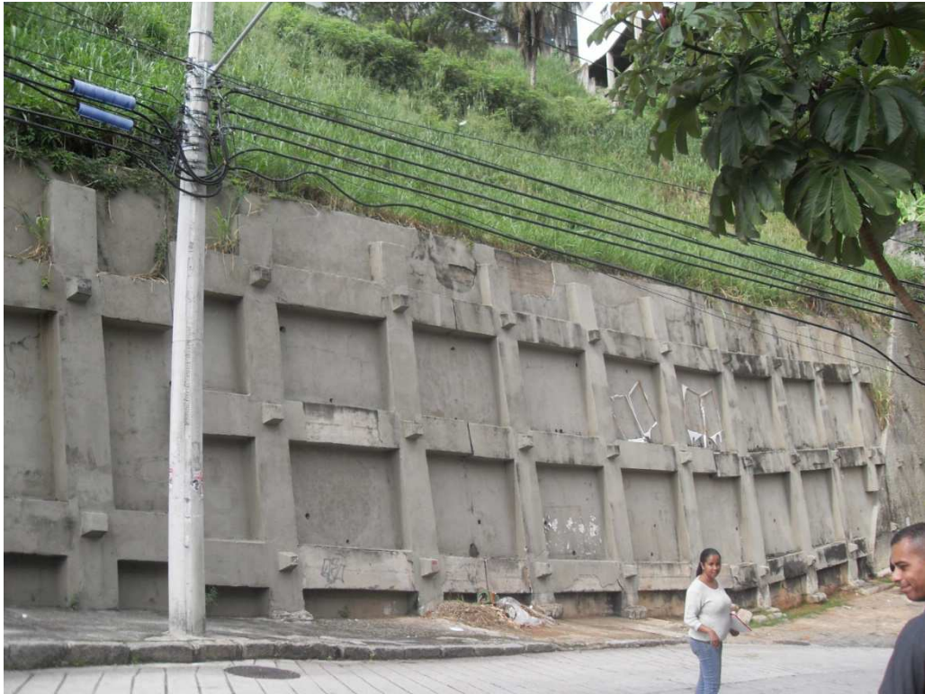
Figura 40. Estruturas de contenção com indícios de ruptura
