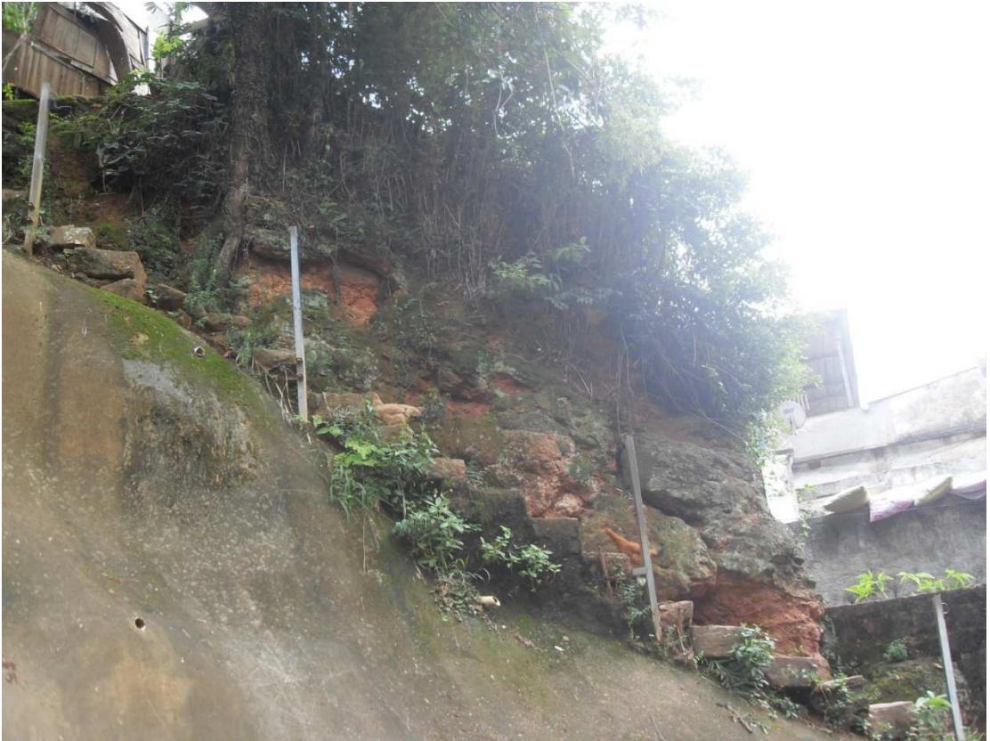
Figura 39. Presença de matacões e erosão superficial
