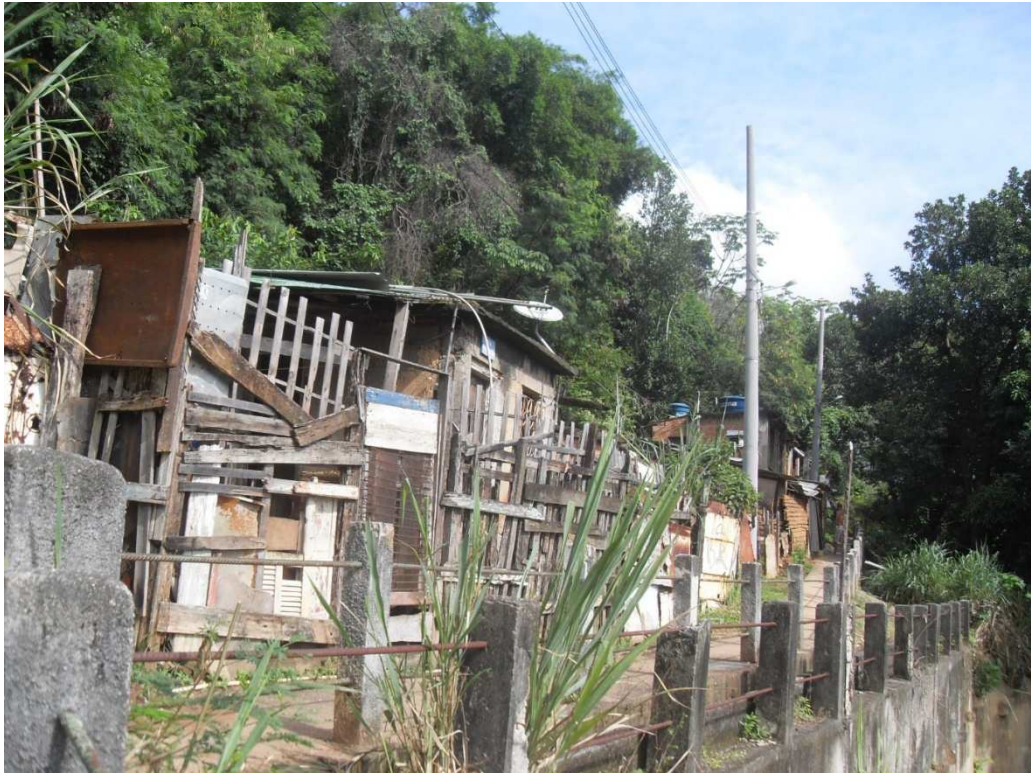
Figura 27. Construções irregulares em área de alto risco
