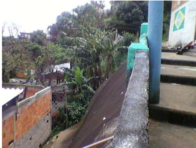
Figura 48. Intervenção estabilizante pontual (concreto projetado)
