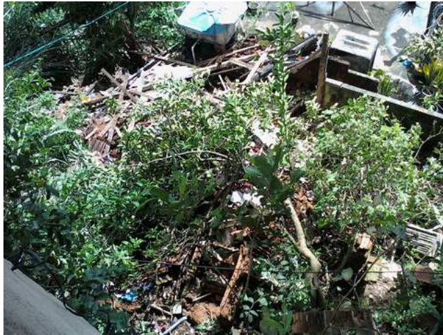
(c) Foto da casa que ruiu espontaneamente em face de sua precariedade estrutural.
