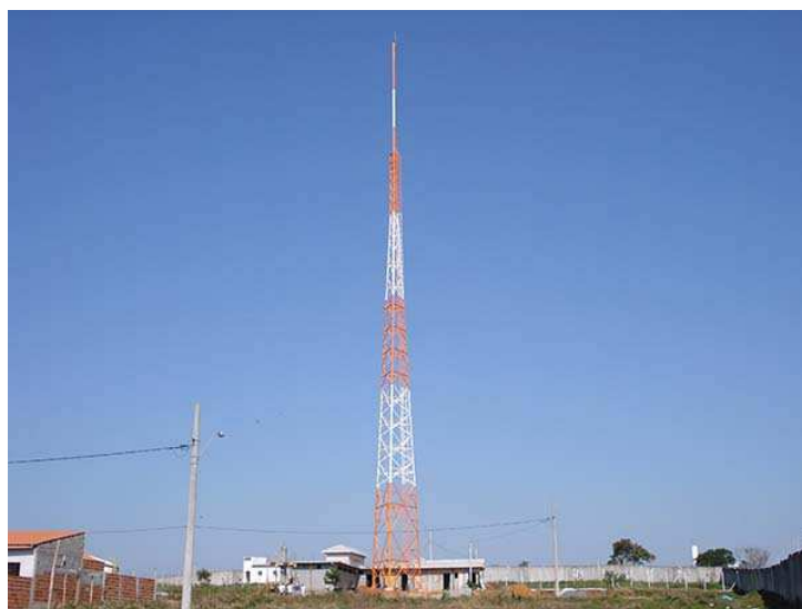
Figura 10: Torre metálica autoportante de chapa dobrada triangular [11].
