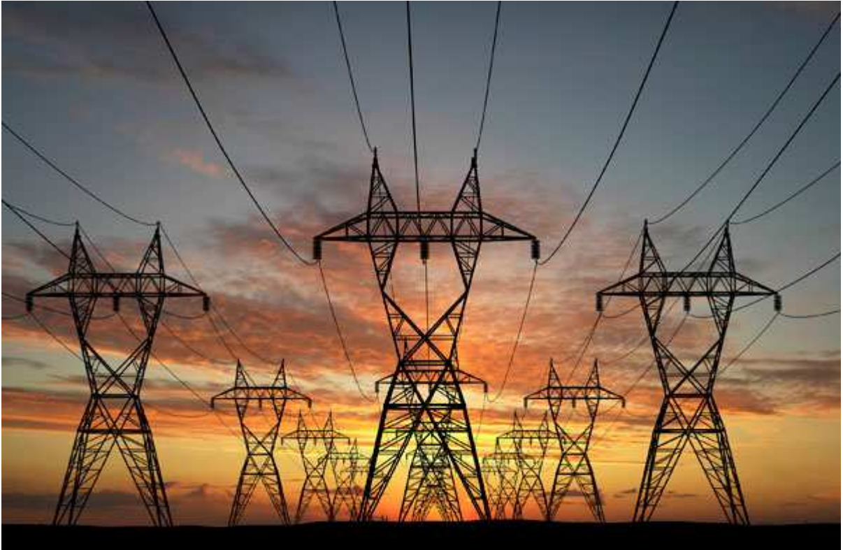
Figura 12: Torres de linhas de transmissão autoportantes [12]
