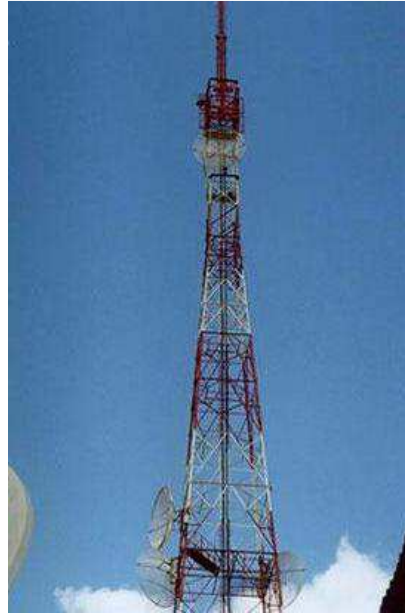
Figura 9: Torre metálica autoportante de cantoneira quadrada [10].
