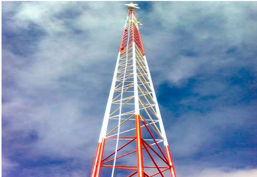
Figura 11: Torre autoportante de tubo triangular [10].
