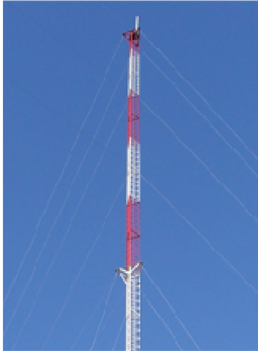
Figura 13: Torre estaiada em aço triangular [13].
