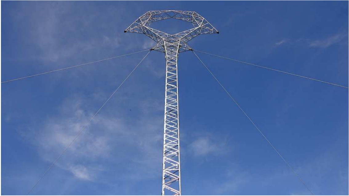
Figura 14: Torre metálica estaiada irradiante [15]
