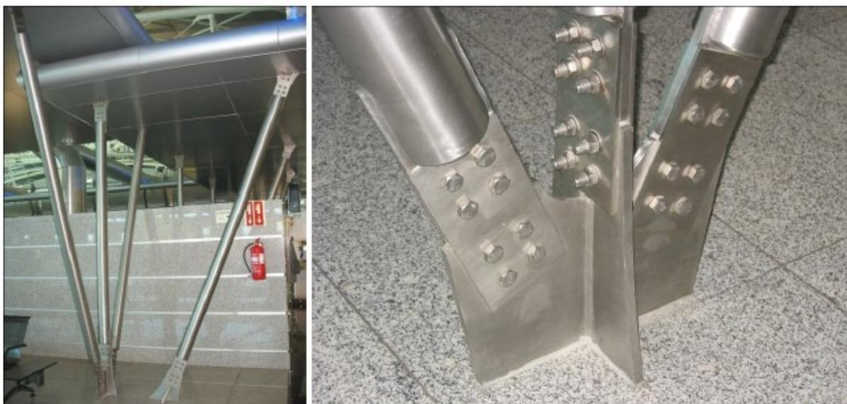
**Figura 7 – Ligação aparafusada em estrutura de aço inoxidável [5]**
