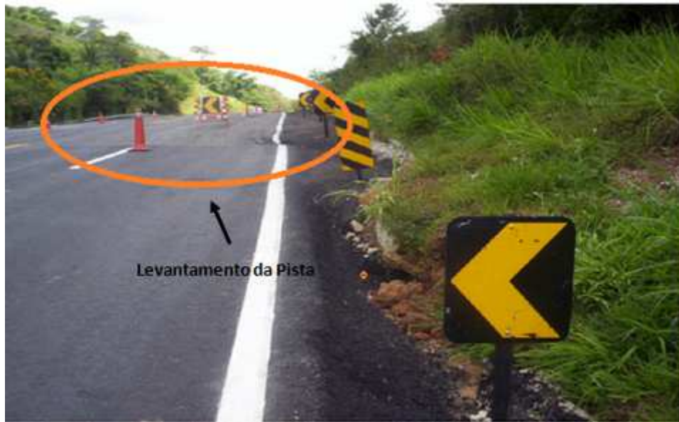
(a) Vista da rodovia
