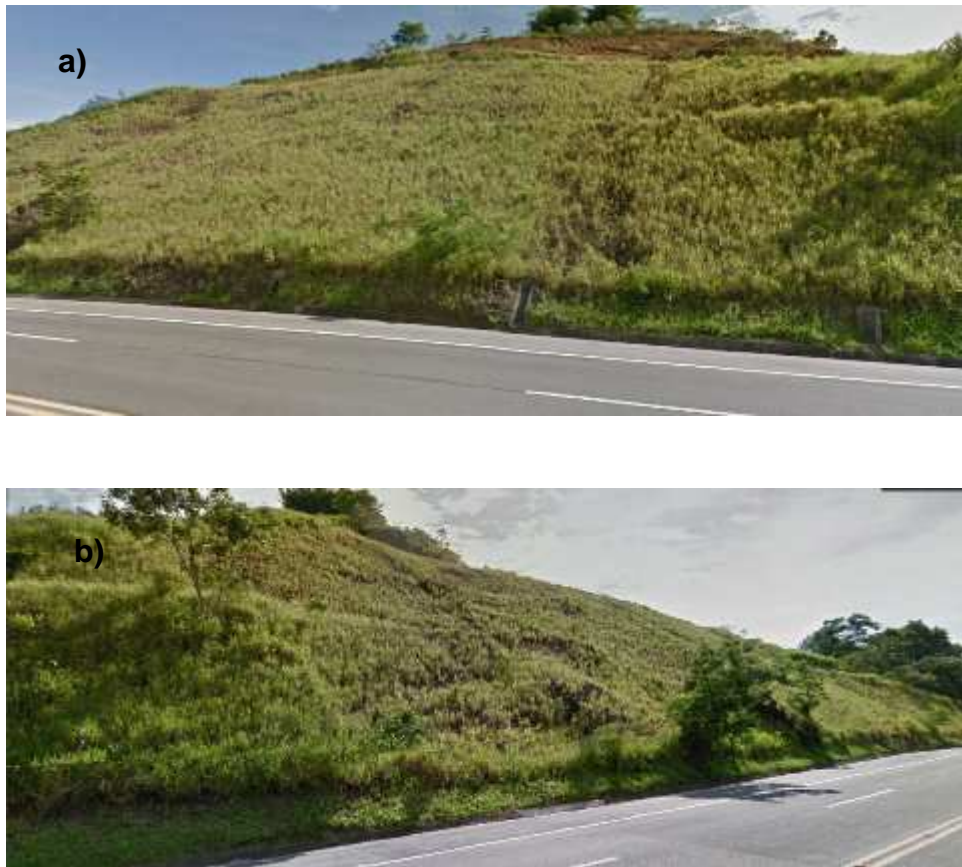
Figura 19 – Fotos do Talude em Estudo: a) Sentido Rio de Janeiro; b) Sentido Cabo Frio.
