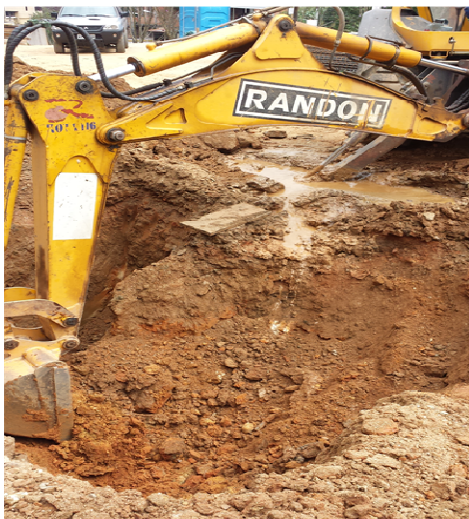
Figura 67 – Detalhe da retirada da amostra indeformada do Solo 2, Prof: 3,00m
