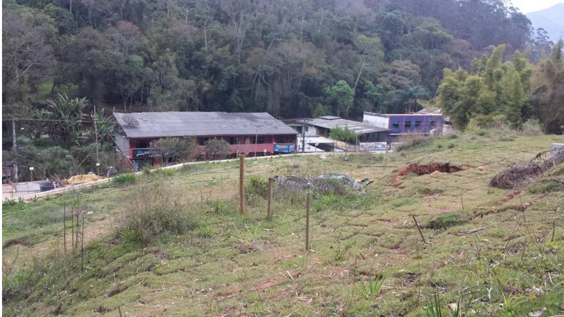
Figura 38 – Detalhe do talude, topo da cortina e comercio local
