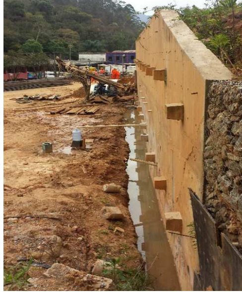
Figura 35 – Detalhe da água no pé da cortina
