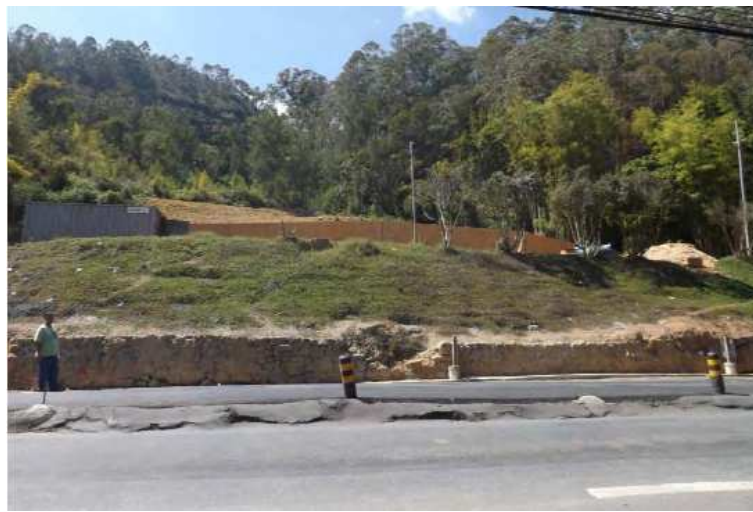
Figura 28 - Detalhe do levantamento da pista: Rodovia RJ 116, km 78
