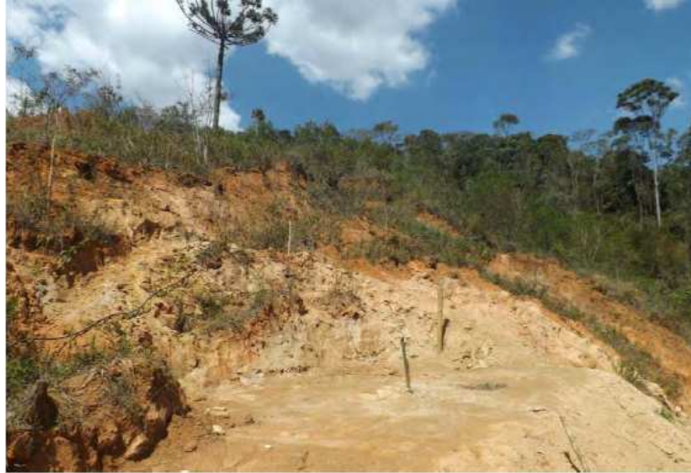
Figura 30 - Detalhe da cicatriz no topo do talude, próximo ao maciço rochoso
