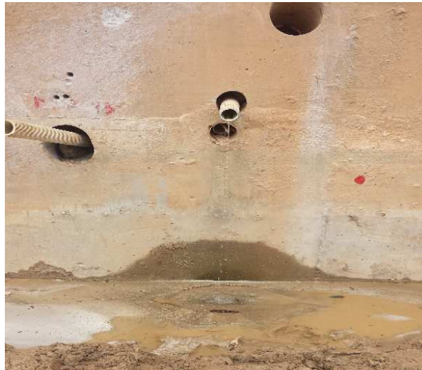
Figura 34 – Detalhe da água saindo dos drenos (período sem chuva)
