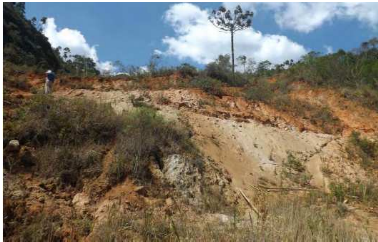
Figura 31 - Detalhe da cicatriz e processo erosivo no topo do talude, próximo ao maciço rochoso
