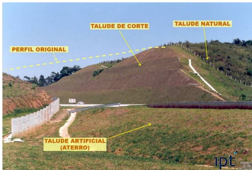
Figura 1 - Taludes naturais e artificiais (IPT, 2014).
