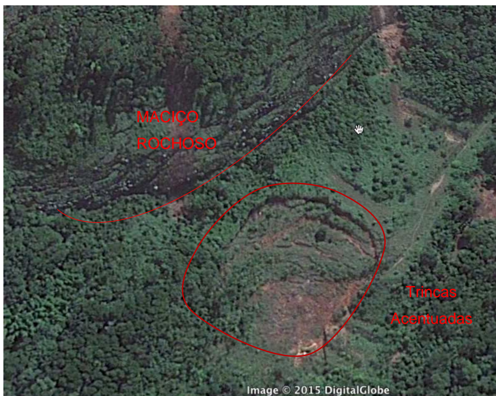
Figura 47 - Detalhe das trincas devido a movimentação do talude, 19/01/2011 (GOOGLE)
