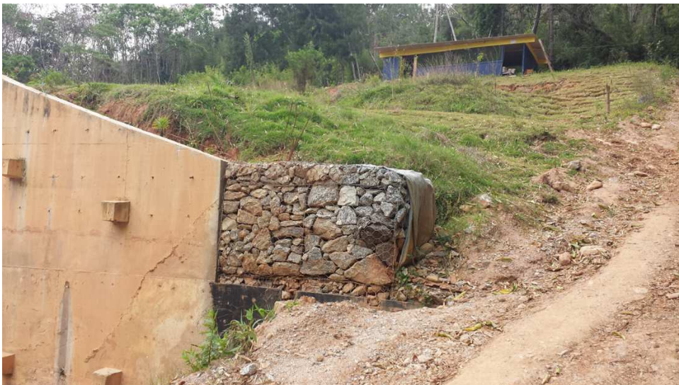
Figura 36 – Lateral da Cortina e parte do talude
