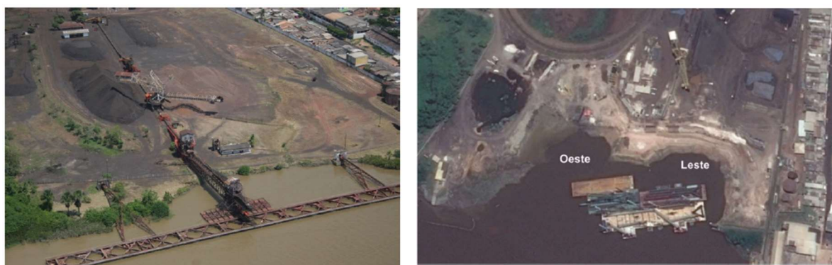
Figura 112 – Foto antes e depois da ocorrência da ruptura, evidenciando a divisão em duas regiões, a leste e a oeste da estrutura transportadora
