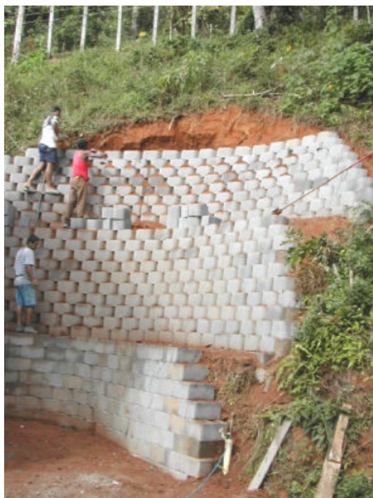
Figura 30 – Solo grampeado em Araras, Petrópolis – Muros Terrae
