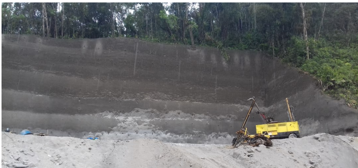
Figura 2 – Solo grampeado Cervejaria Imperial – Bingen - Petrópolis (arquivo pessoal - 2016)
