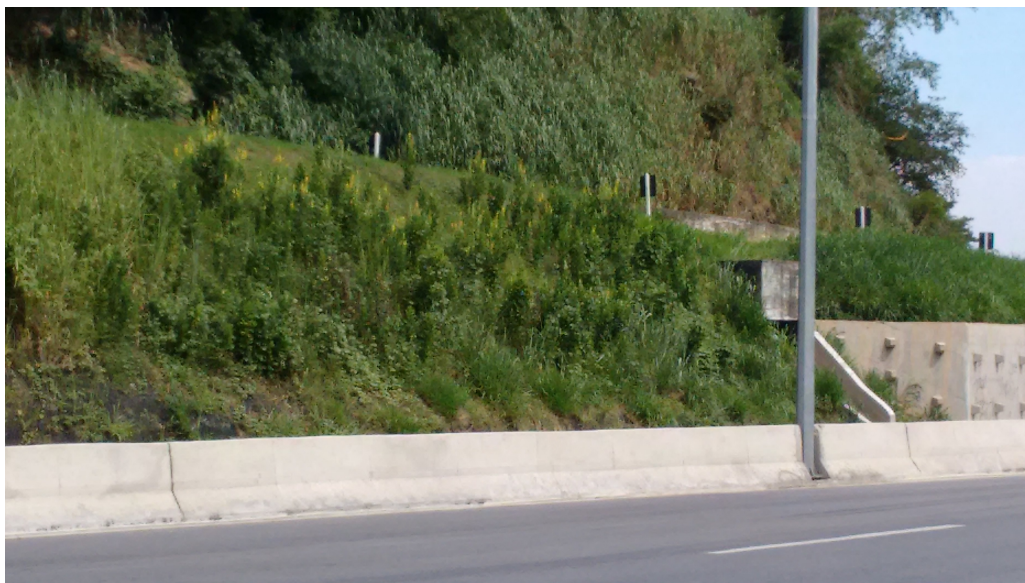
Figura 12 - Solo grampeado com revestimento vegetal – Praça do Pedágio – subida Petrópolis (arquivo pessoal 2015)
