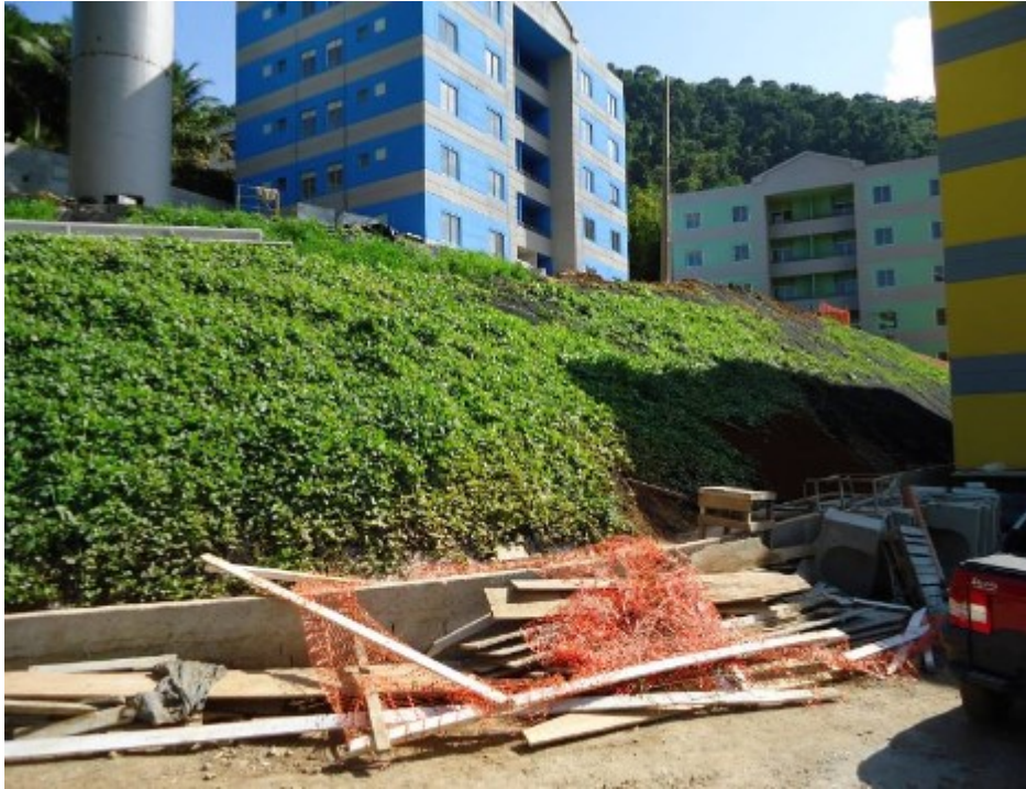
Figura 25 – Final da obra em Angra dos Reis (Maccaferri, 2011) – Revestimento vegetal
