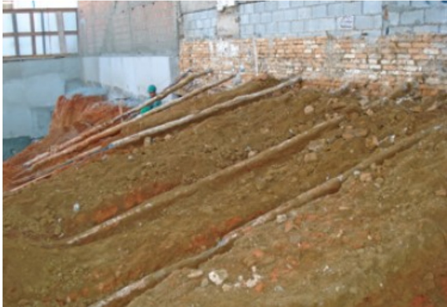
Figura 34 – Detalhes da escavação dos grampos da construção do Ed. Astor (Souza et al, 2007)
