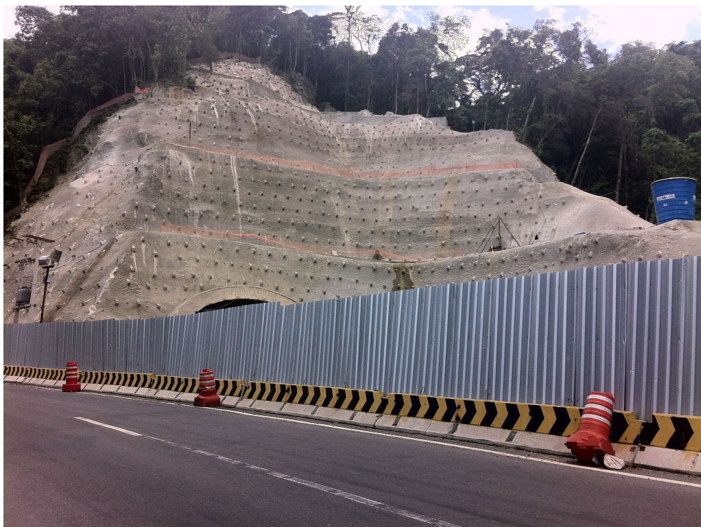
Figura 4 – Nova subida da Serra de Petrópolis ( arquivo pessoal – 2015 ) – Emboque do túnel escavado e ao lado, talude natural.
