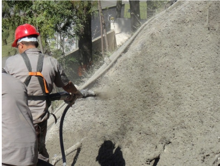
Figura 20 – Aplicação: concreto projetado com fibra metálica ( www.neomatex.com.brconcreto-fibras-polipropileno , 17/08/2015, 17:24)
