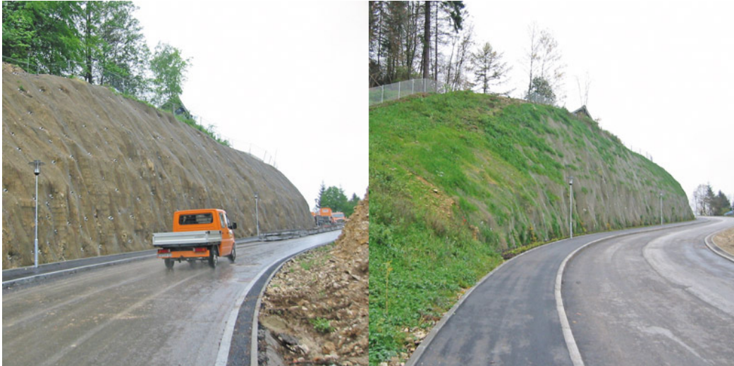
Figura 27 – Revestimento com tela TECCO de alta resistência – Geobruigg
