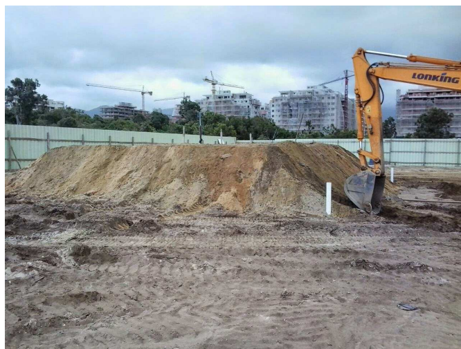
Figura 31 – Aterro teste finalizado, com os instrumentos instalados e sobrecarga aplicada.
