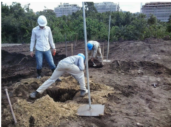
(a) Locação das placas de recalque.
