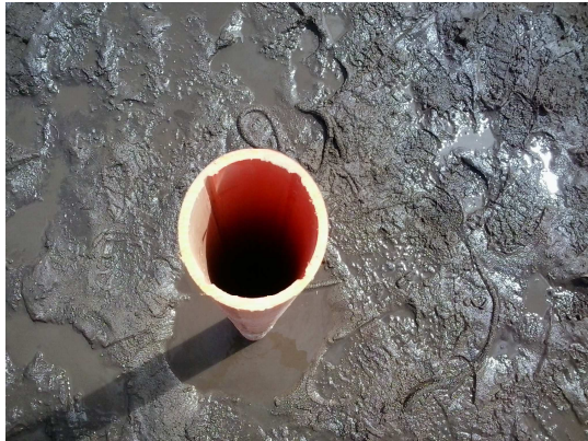
(a) Instalação do tubo guia.
