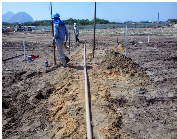
Figura 45 – Instalação do tubo na base do aterro.
