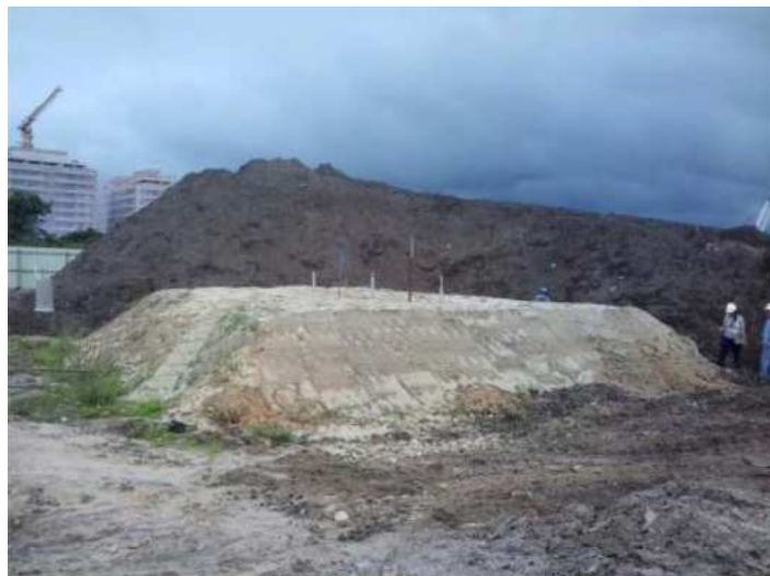
Figura 52 – Material de descarte depositado próximo ao aterro teste A.
