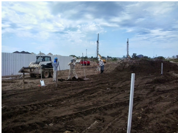
Figura 30 – Instalação dos instrumentos.
