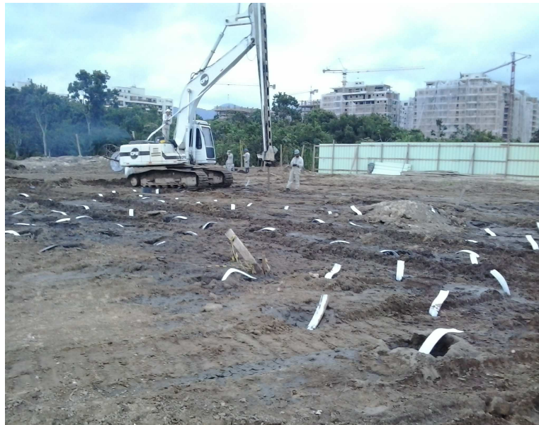
Figura 28 – Cravação dos geodrenos na área do aterro teste.
