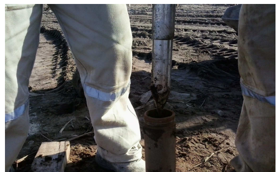
(b) Introdução do piezômetro.
