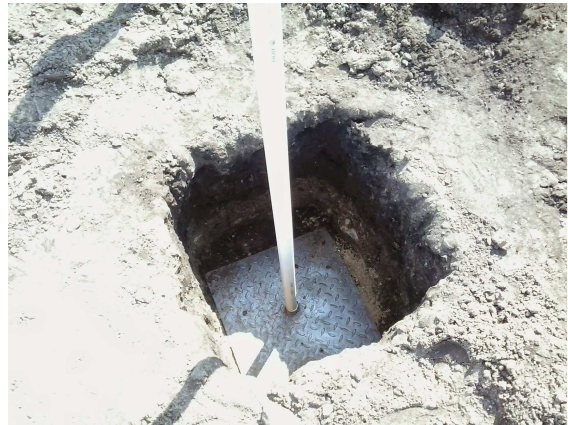
(b) Placa de recalque instalada.
