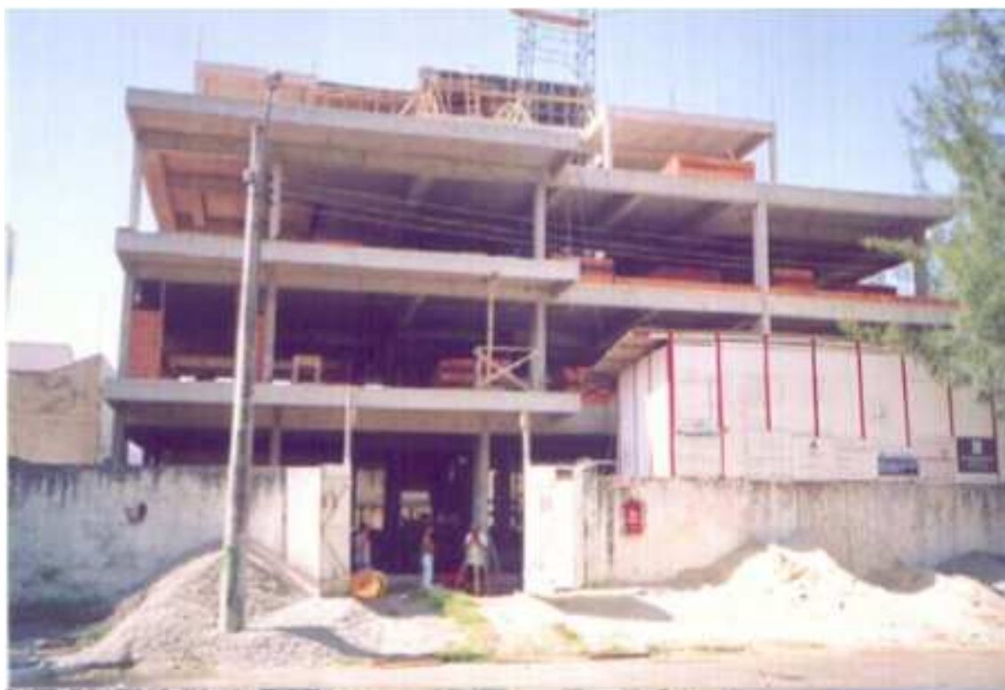
Figura 10 – Vista Geral da edificação durante a sua construção (BRAUNE et al 2008).
