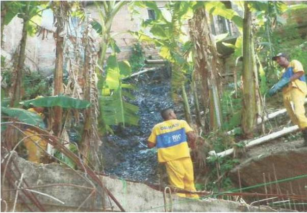
Figura 64: Limpeza, retirada de lixo e regularização de talude (GEO-RIO I, 2011)
