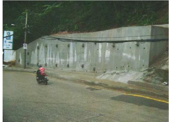
Figura 78: Portão Vermelho – vista de trecho para construção de cortina e contrafortes atirantados – início da execução das intervenções (GEO-RIO II, 2011)
