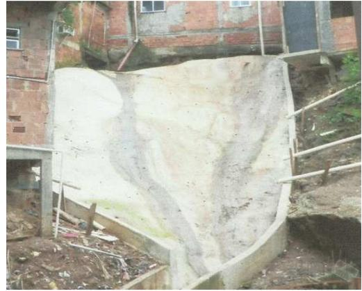
Figura 65: Trecho com concreto projetado e viga de concreto armado estaqueada, concluídos (GEO-RIO I, 2011)
