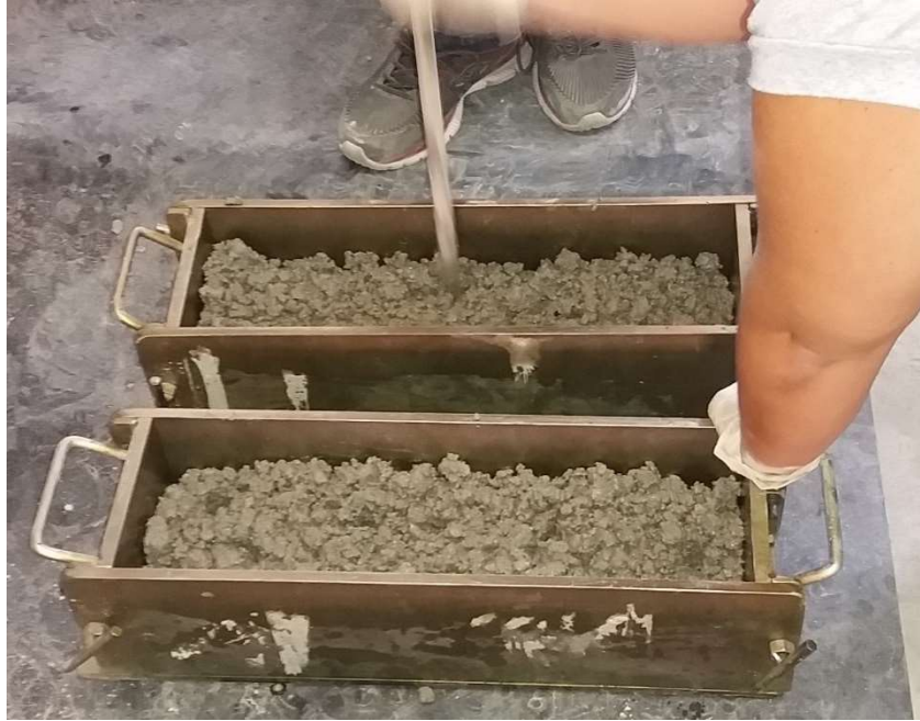
Figura 35 – Compactação manual dos prismas
