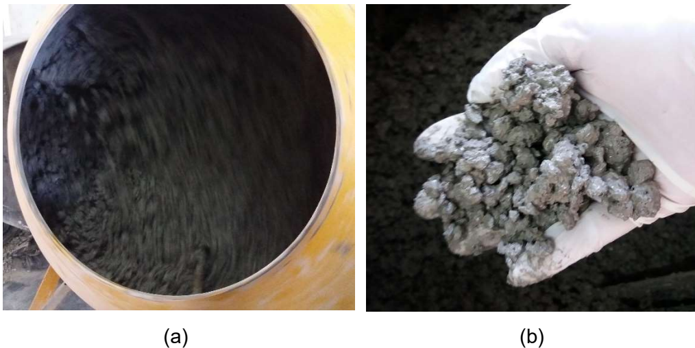
Figura 33 – (a) Etapa final da concretagem; (b) Análise tátil visual do concreto
