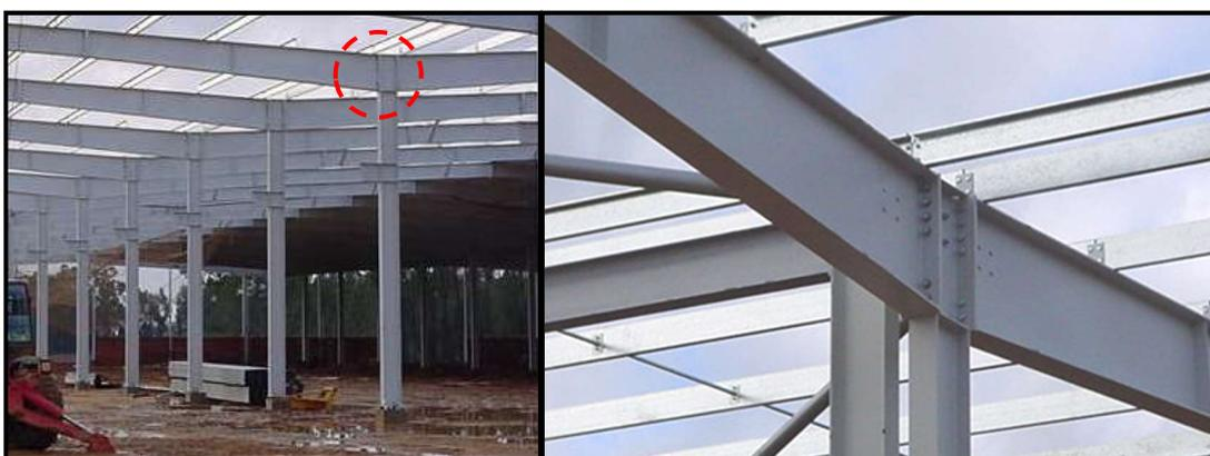
Figura 12 - Ligação de um pórtico de galpões com vigas inclinadas [30]
