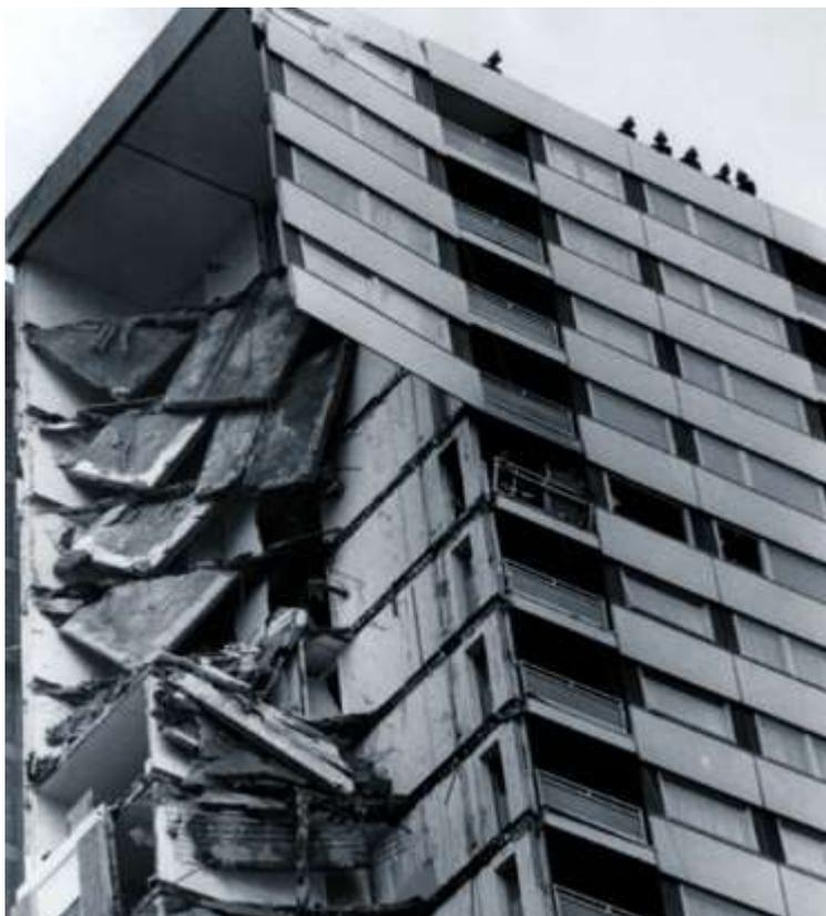
Figura 5 – Detalhe da região onde houve a explosão de gás do edifício Ronan Point/Londres em 1968 que ocasionou o colapso progressivo [10]
