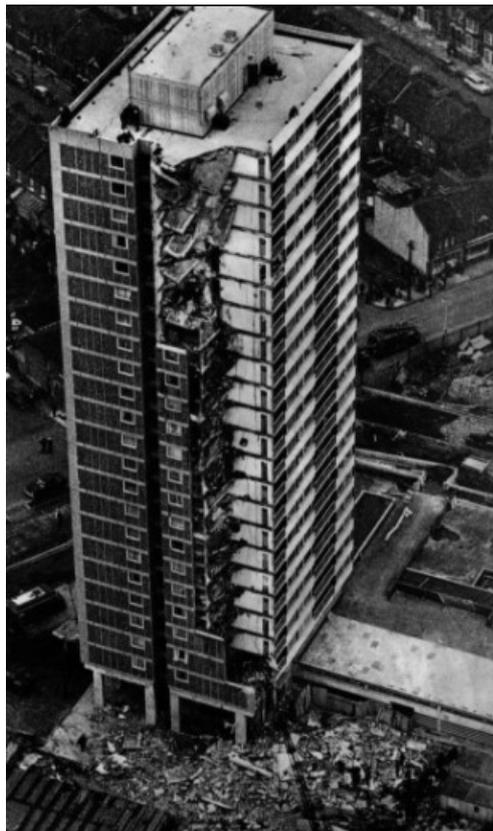
Figura 1 - Colapso progressivo do edifício Ronan Point/Londres em 1968 devido a uma explosão de gás [1]
