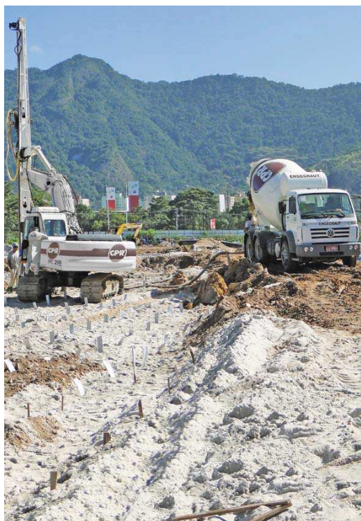
Figura 51 - Fase de cravação de geodrenos (Engegraut, 2017).
