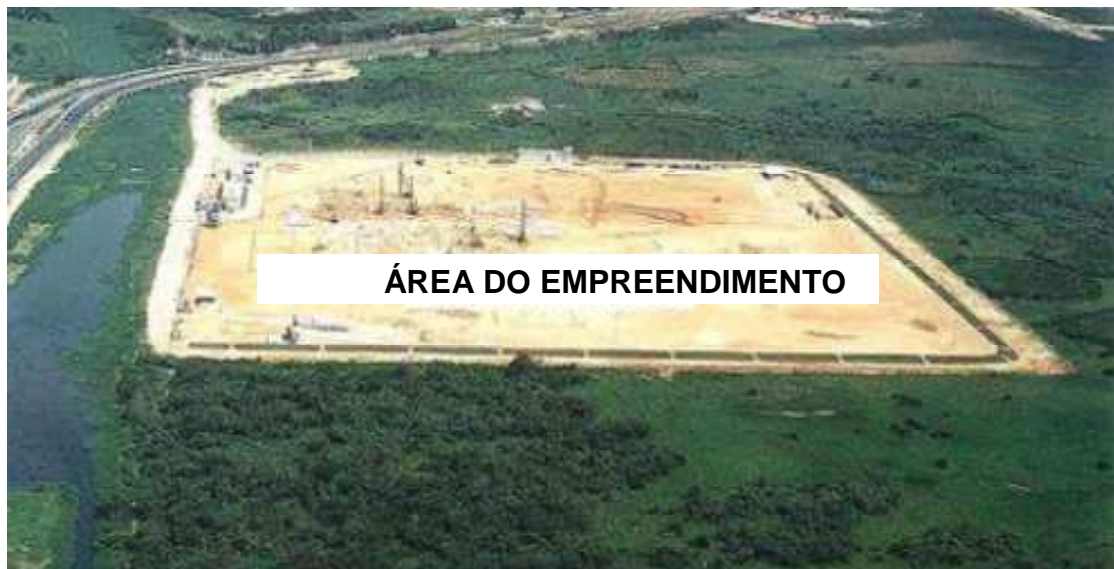
Figura 15 - Fase inicial da construção, adaptado de Spotti (2006)
