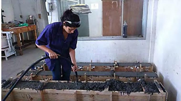
**Figura 37 – Adensamento da mistura com vibrador.**
