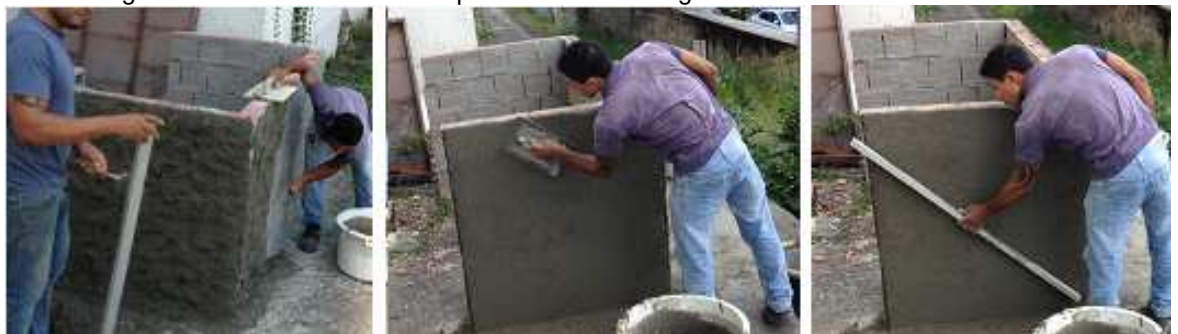
Figura 46 - Revestimento das paredes com as argamassas estudadas
