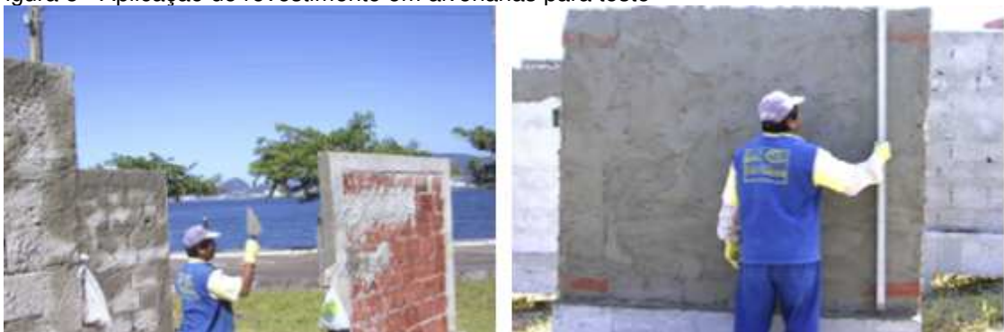
Figura 8 - Aplicação de revestimento em alvenarias para teste
