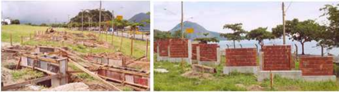
Figura 6 - Construção de alvenarias para testes
