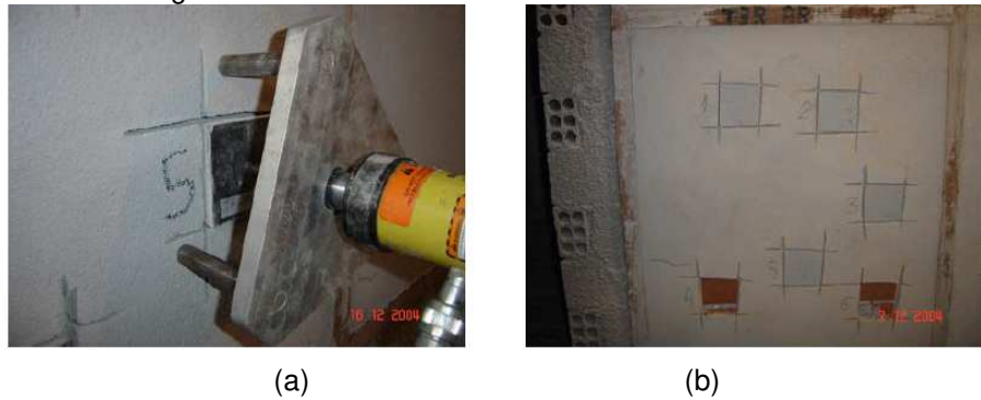
Figura 12 - Teste de aderência nas alvenarias
