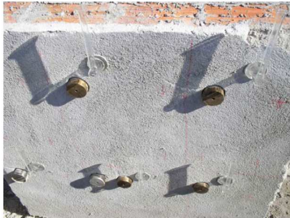
Figura 15 - Teste de aderência e permeabilidade em alvenaria
