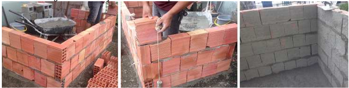
Figura 45 Execução de alvenaria para testes de revestimento
