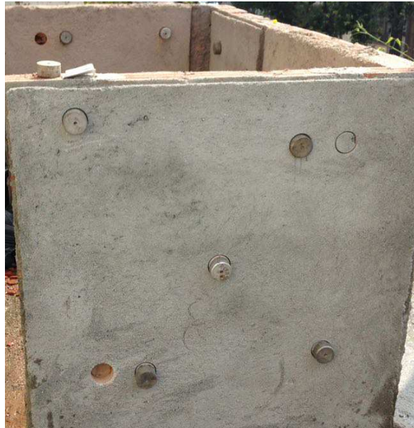
Figura 49 Parede com pastilhas coladas para ensaio
