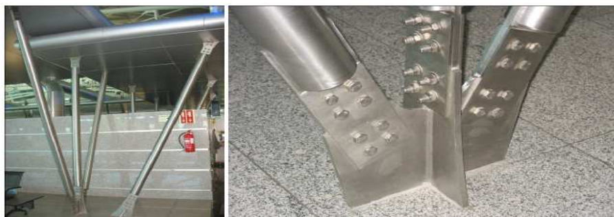
Figura 3 – Ligação aparafusada em estrutura de aço inoxidável [5].
