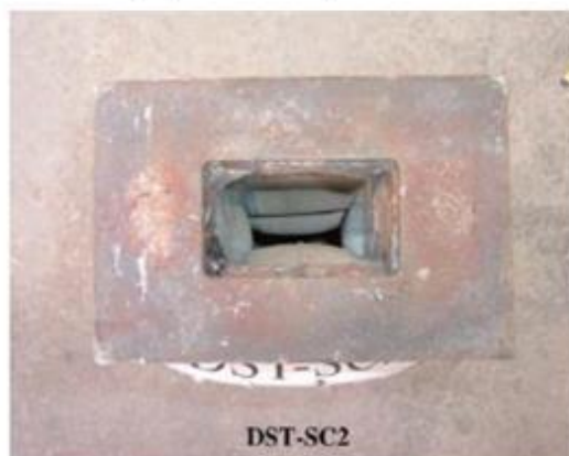
(b) Modo de falha do tubo interno de perfil RHS
