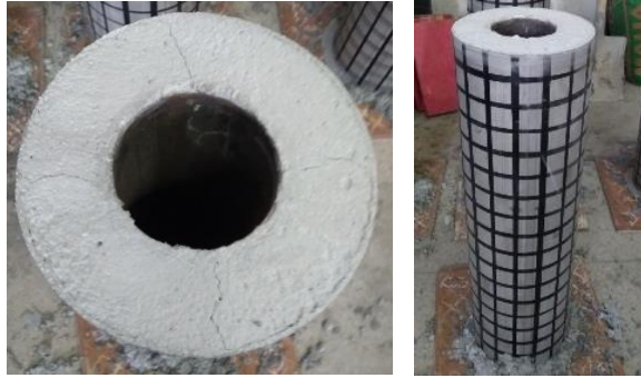
Figura 35 – Coluna CFDST após a concretagem
