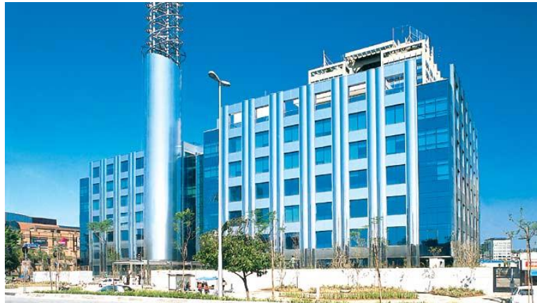
Figura 7 - Prédio administrativo da VIVO com fachadas revestidas com aço inoxidável [17].
