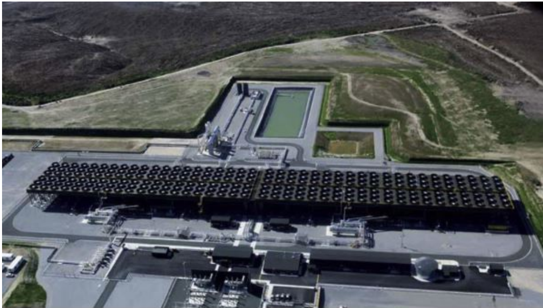
Figura 3 - Usina de ciclo de Rankine orgânico com fonte geotérmica com geração de 100MW em Nova Zelândia, ano 2013
