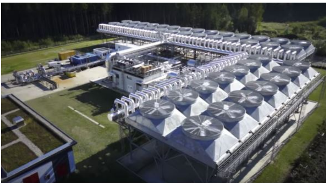
Figura 5 - Usina de ciclo de Rankine orgânico com geração de 5,6 MW em Durrnhaar, Alemanha, ano 2013
