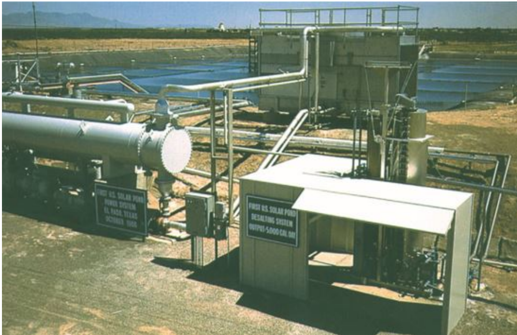
Figura 1 - A unidade de CRO de energia solar com 70 kW em El Paso, Texas, ano 1985
