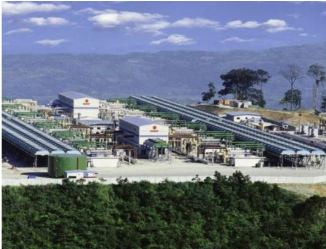
Figura 2 - Usina de ciclo de Rankine orgânico com fonte geotérmica com geração de 130MW em Upper Mahiao, Filipinas, ano 1996
