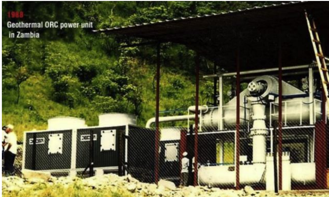
Figura 4 - Usina de ciclo de Rankine orgânico com geração de 100 kW em Zâmbia, ano 1988
