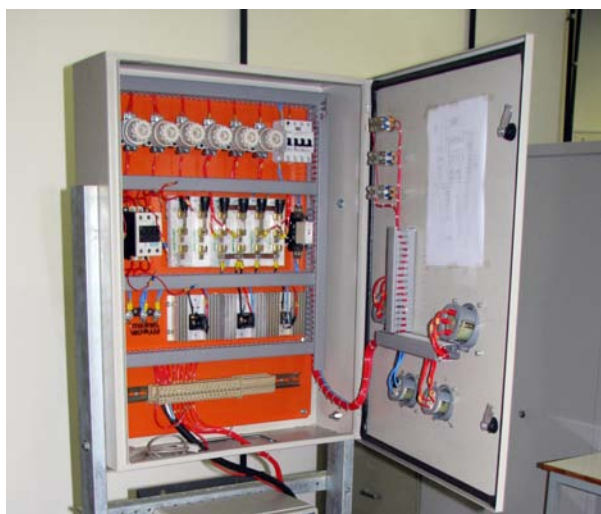
Figura 72: Foto do painel com os dispositivos de potência. (Foto tirada pelo autor)
