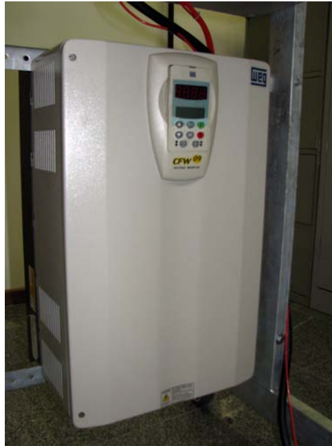
Figura 75: Foto do inversor de potência WEG CFW09. (Foto tirada pelo autor)
