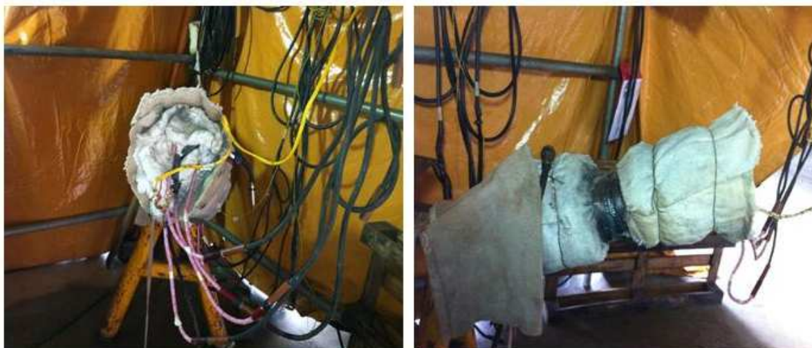
Figura 3. Junta com isolamento térmico.
