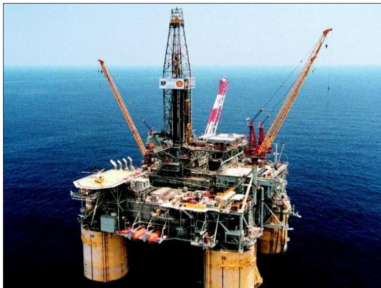
Figura 22 - Plataforma da Petrobras P-56
